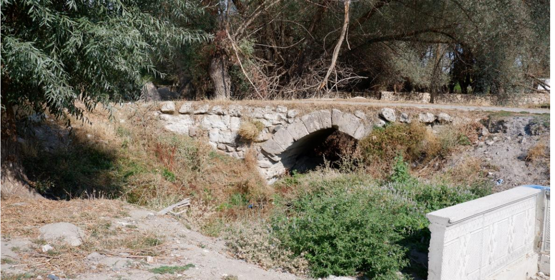
Foto 9. Ağzıkara Han Köprüsü (15.09.2021).
