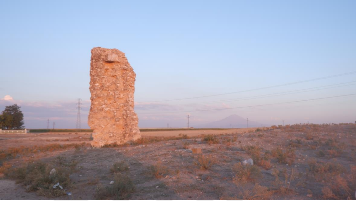
Foto 7. Akhan Kervansarayı Kalıntısı (14.09.2021)
