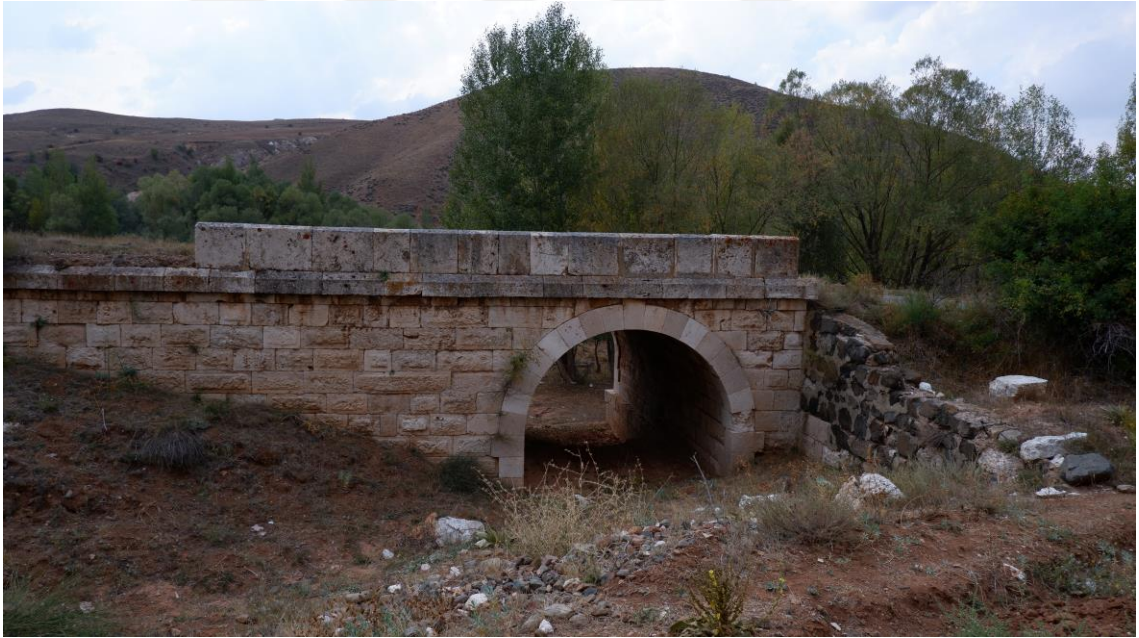
Foto 18. Çallı Deresi Üzerindeki Tarihi Köprü (16.09.2021).
