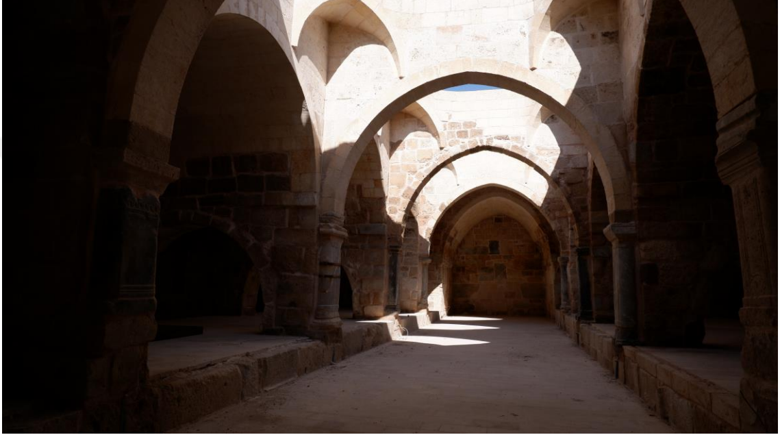
Foto 21. Obruk Kervansarayı İç Mekânından Bir Görünüm (16.09.2021).
