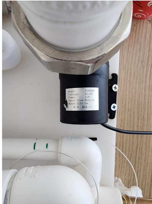
Şekil 11. Sirkülasyon Pompası
