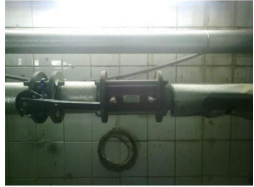
Şekil 18 IR133 Sıcak Su Kazan Tesisatı Kompanzatör
