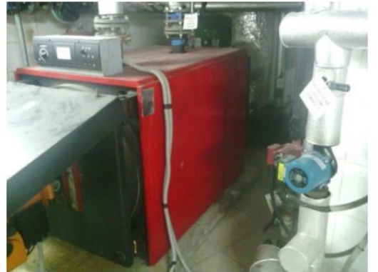
Şekil 15 IR130 Sıcak Su Kazanı Sağ Yan Yüzey
