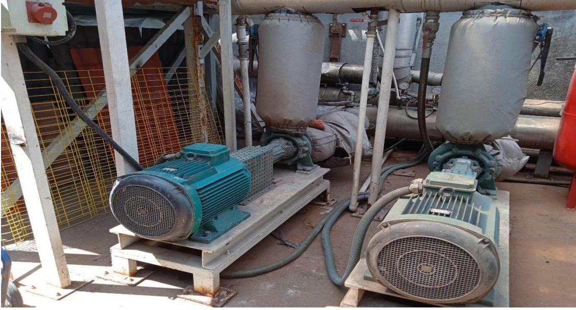
Şekil 47: Pompa 2 Genel Görüntüsü
