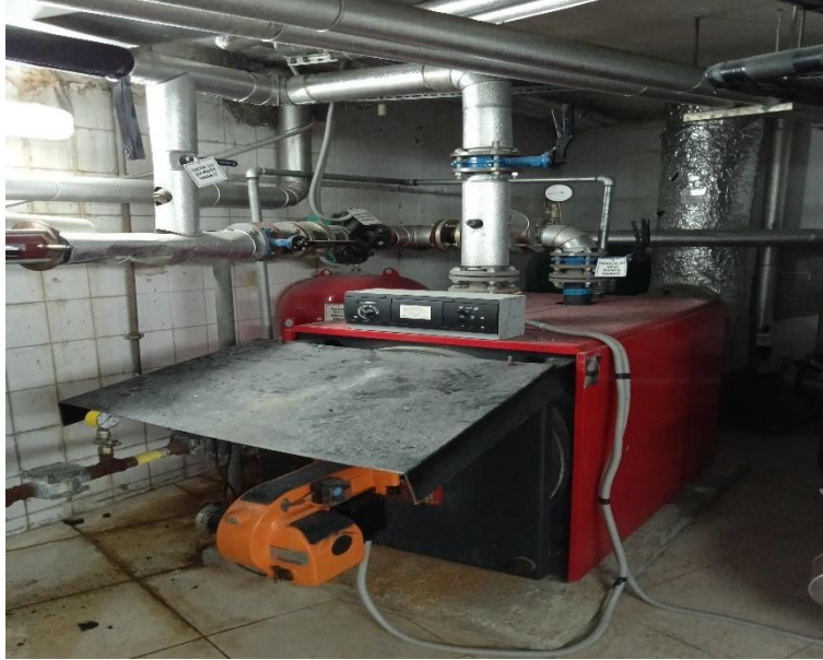
Şekil (1): SıcakSu Kazanı
