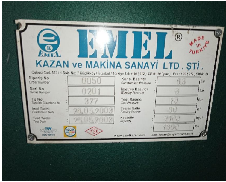
Şekil 4: Buhar Kazanı Etiket Bilgisi
