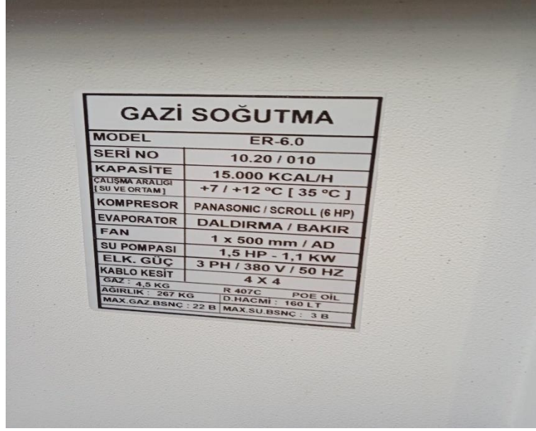
Şekil 37: Duramit 4 Chiller Etiketi
