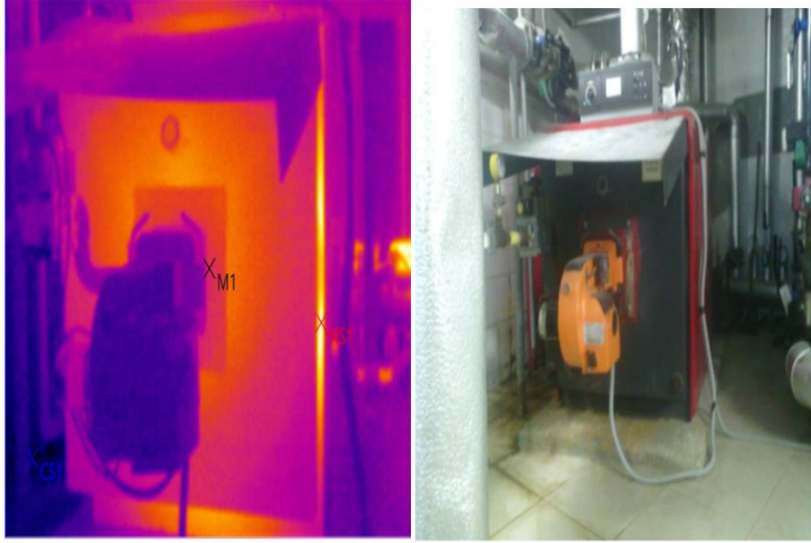
Şekil 5: Sıcak Su Kazanı Ön Yüzey
