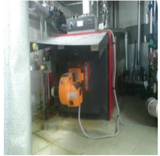
Şekil 14 IR129 Sıcak Su Kazanı Ön Yüzey
