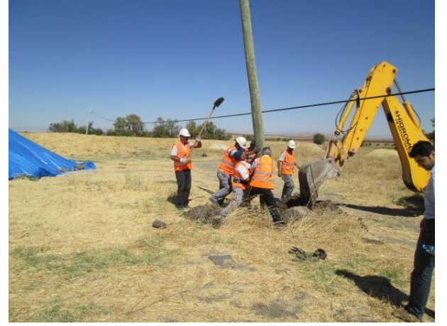
Şekil 5. Ahşap Telefon Direği Dikim İşlemi
