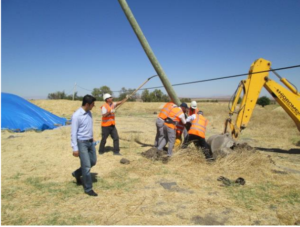
Şekil 5. Ahşap Telefon Direği Dikim İşlemi
