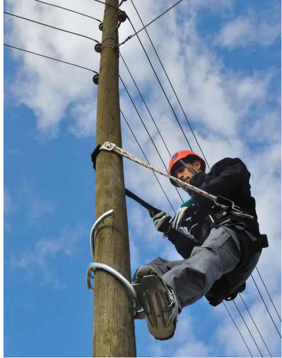
Şekil 7. Ayakçak ile Direğe Çıkma
