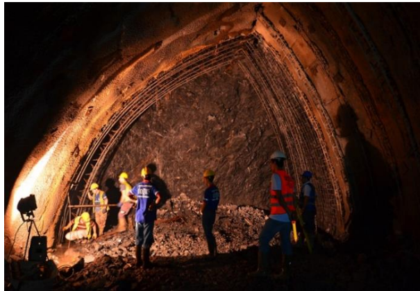
Şekil 31. Üsküdar -Ümraniye - Çekmeköy Metrosu’nda uygulanan NATM üst yarı çalışması (Üsküdar Ümraniye Çekmeköy Sancaktepe Metrosu, t.y.)
