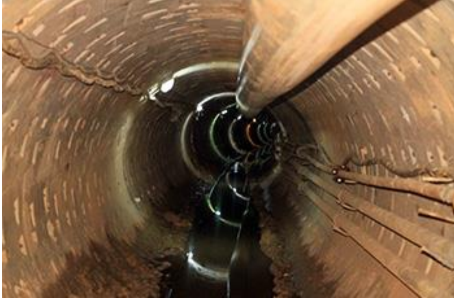
Şekil 1. Kanalizasyon tüneline ait örnek görsel (Kocaeli Büyükşehir Belediyesi, 2017)
