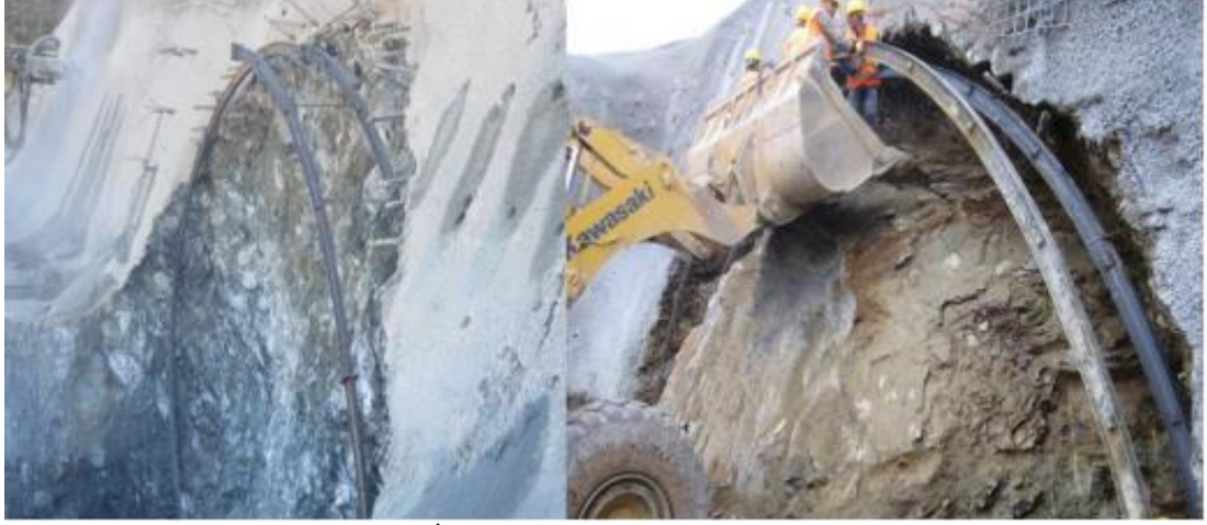
Şekil 29. Tünel Ekseninde Çelik İksa Uygulaması (Çoruh, Köksal, Kaplan, & Demirci, 2017)
