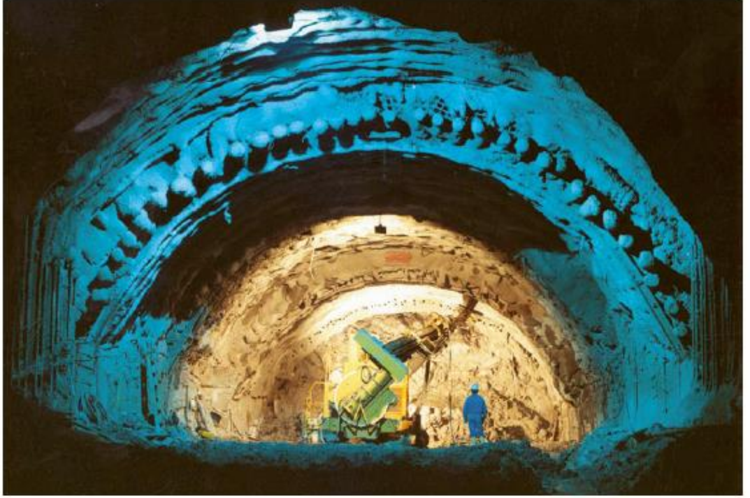
Şekil 18. İtalya Solignano tüneli ön süren uygulanmasının gösterimi (Polat, 2010)
