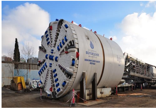
Şekil 30. Üsküdar – Ümraniye - Çekmeköy Metrosu yapımında kullanılan TBM (Üsküdar Ümraniye Çekmeköy Sancaktepe Metrosu, t.y.)
