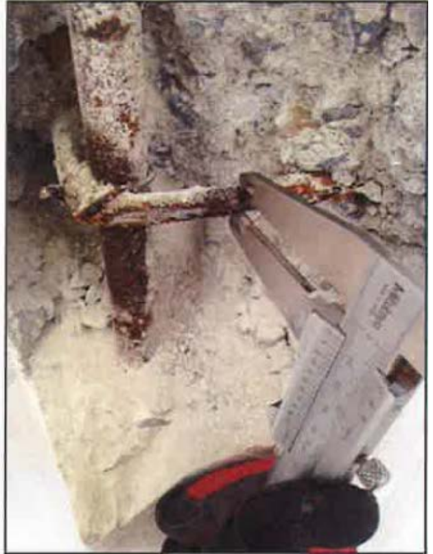
Şekil 10. Bina betonarme yapı elemanları donatılarındaki aşırı korozyon
