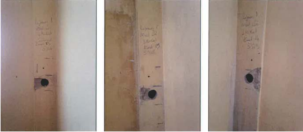
Şekil 7. Binadan alınan beton karot yerleri ve belirlenen donatı aralıkları
