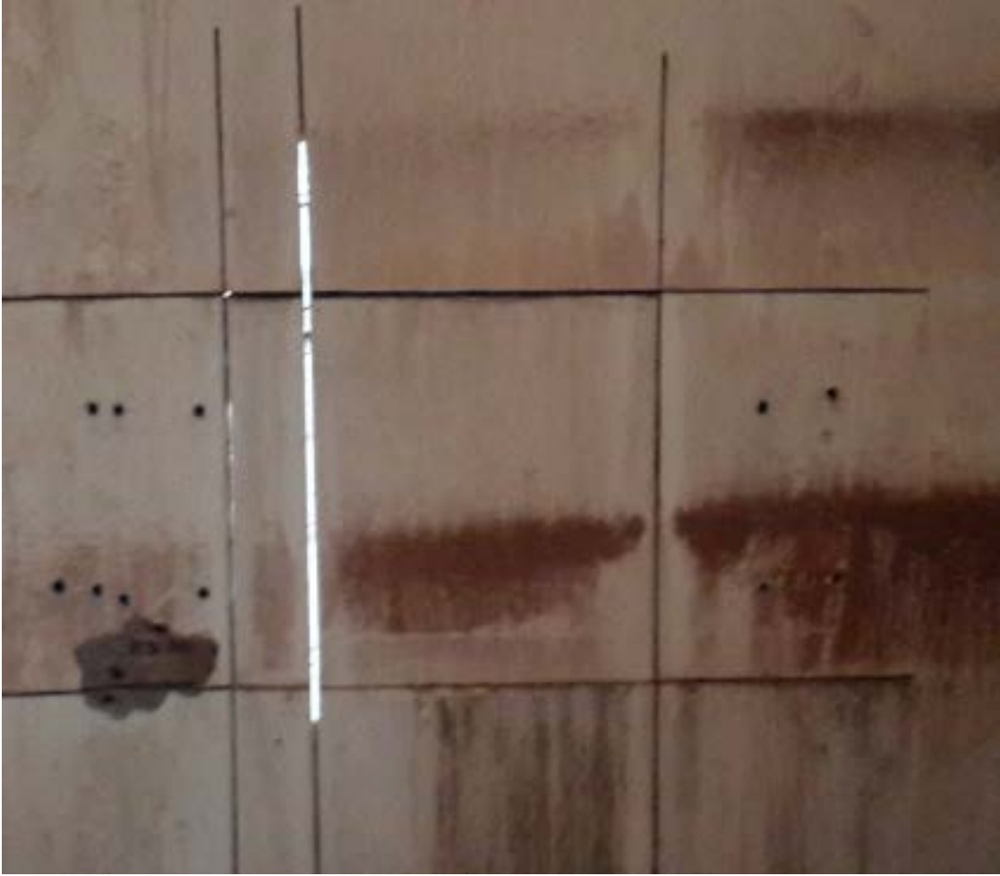
Şekil 31. Laboratuvarda test edilmek üzere kesilmiş duvar
