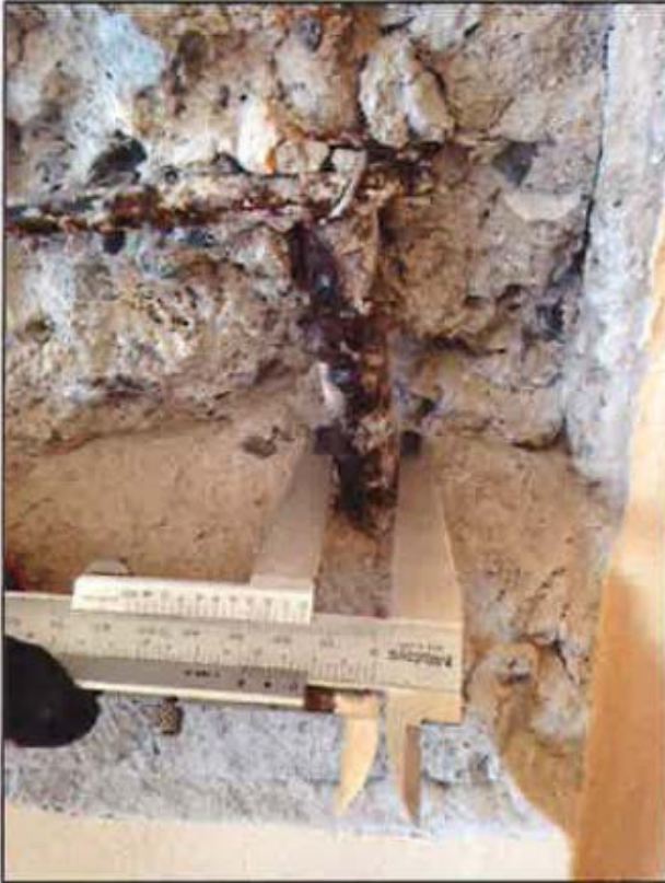
Şekil 10. Bina betonarme yapı elemanları donatılarındaki aşırı korozyon
