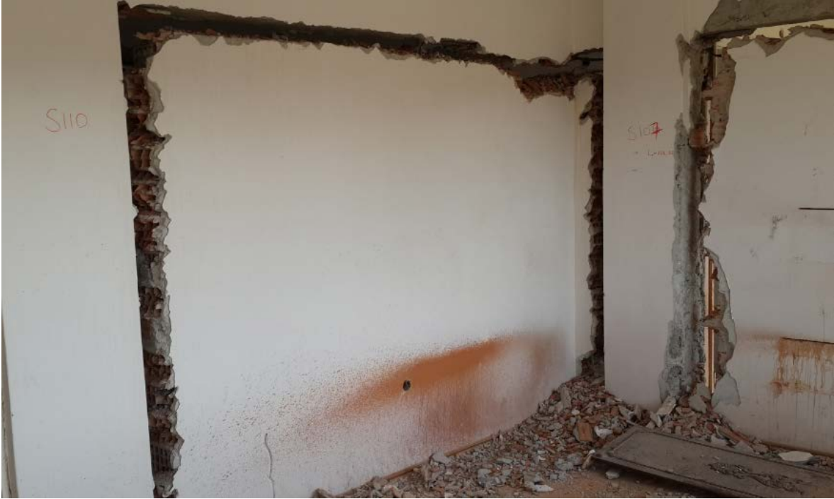
Şekil 26. Duvar ayırma sonrasında yapı içinden görünüş
