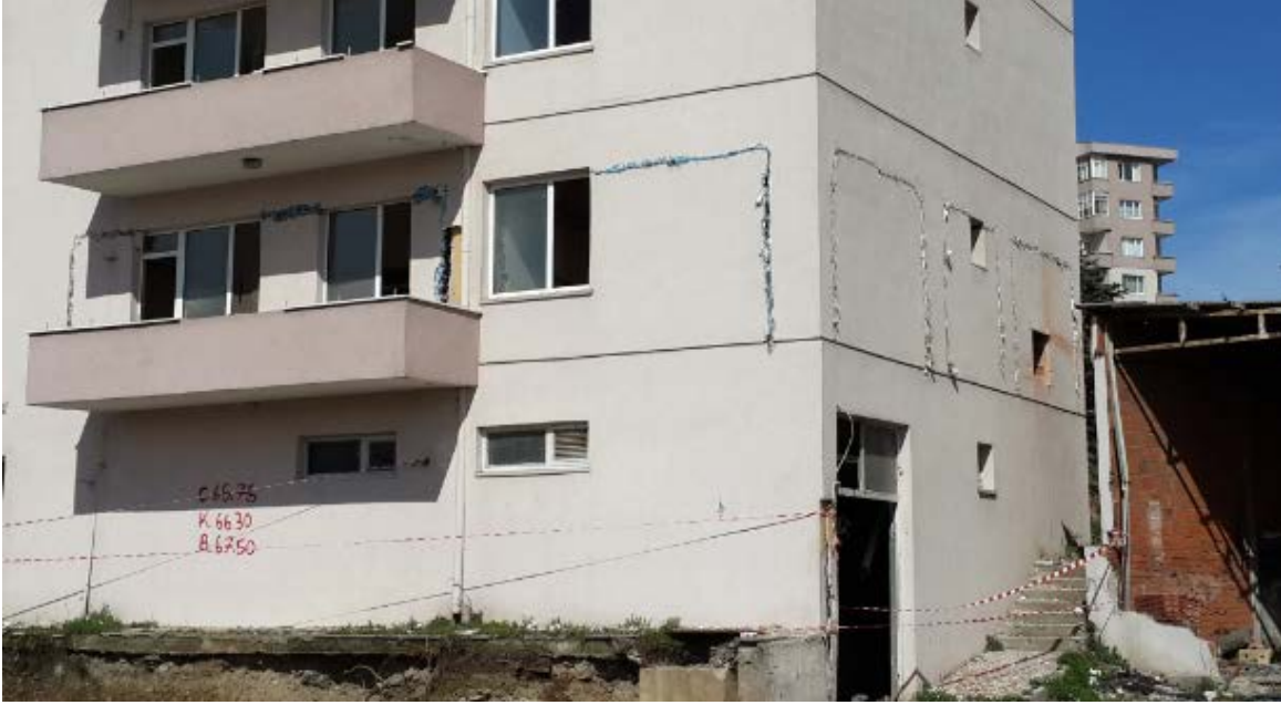
Şekil 27. Duvar ayırma işlemi sonrası yapının dışarıdan görünüşü
