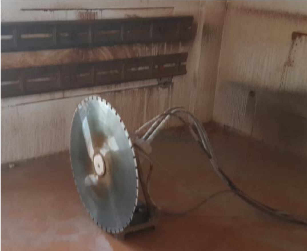
Şekil 30. Duvar kesme işleminde kullanılan testere
