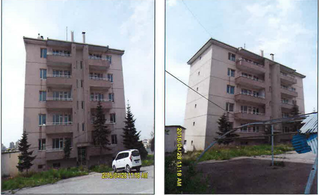
Şekil 1: Lojman-1 ön ve yan cephe görünüşü
