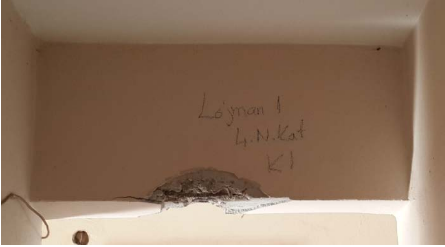
Şekil 9. Binada yapılan kiriş sıyırma işlemi
