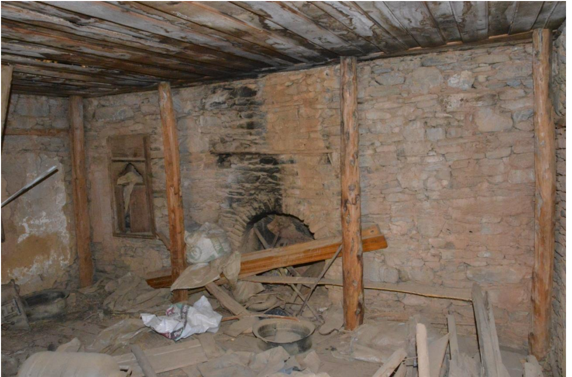
Fotoğraf 44- Yapının doğu duvarı
