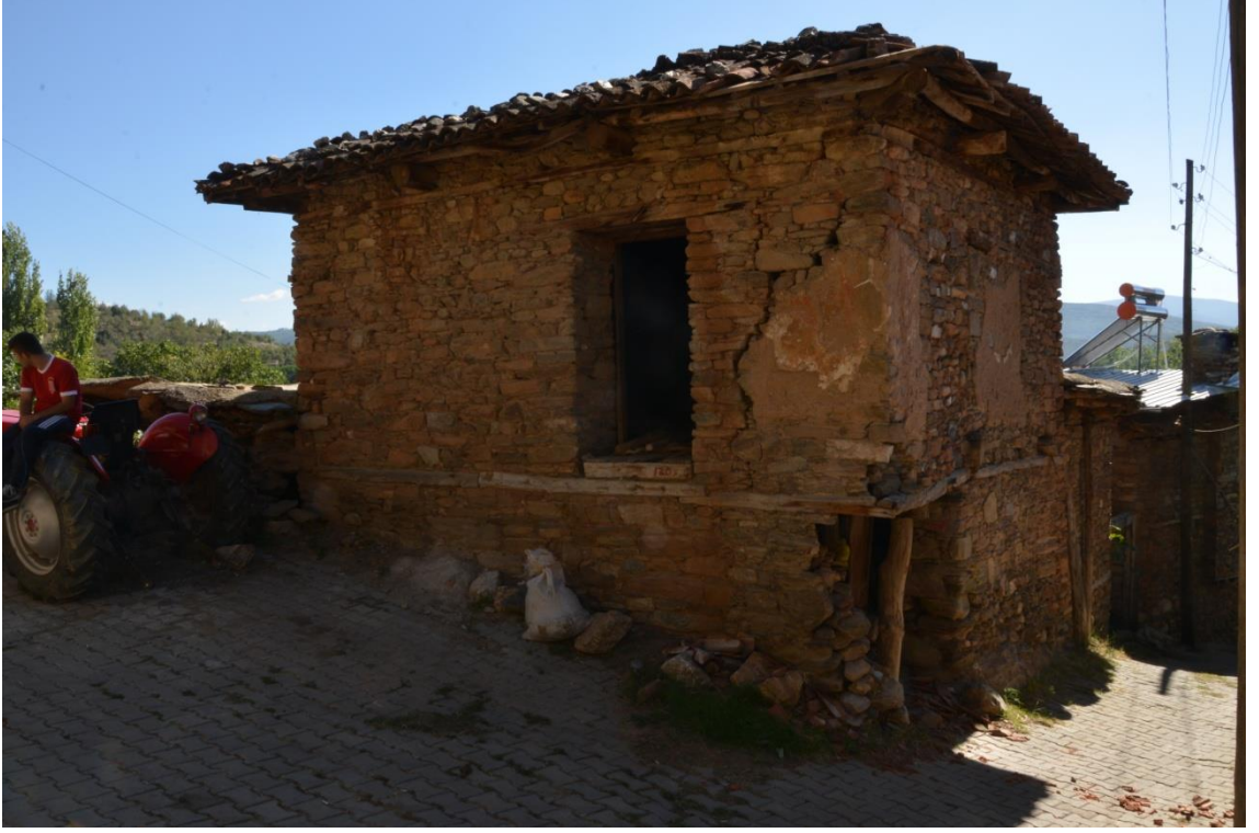
Fotoğraf 41- Hacı Kâhyalar Odası'nın dıştan görünüşü
