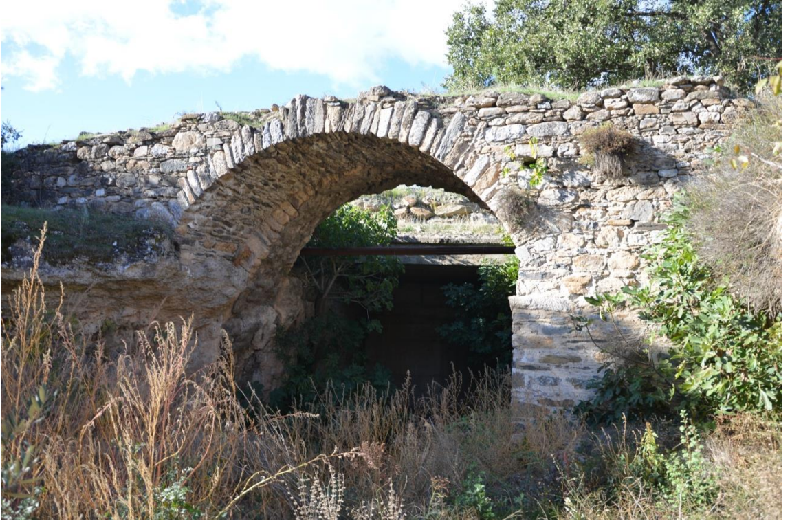
Fotoğraf 54- Tek Göz Köprüsü'nün kuzey taraftan görünüşü
