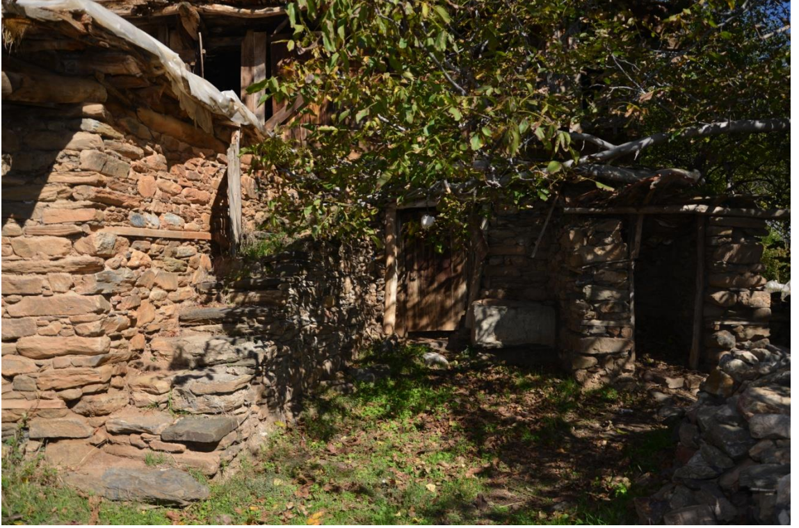
Fotoğraf 81- Osman Şen Evi'nin giriş cephesi
