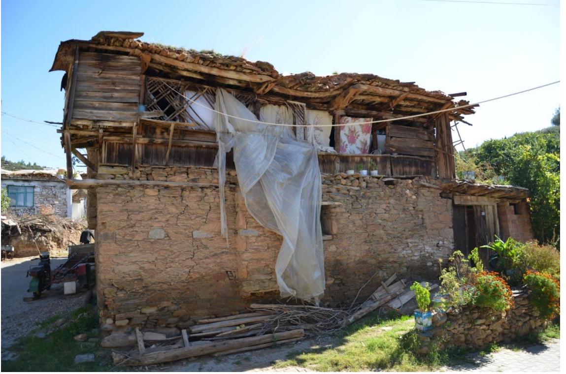
Fotoğraf 63- Evin ön cephesi
