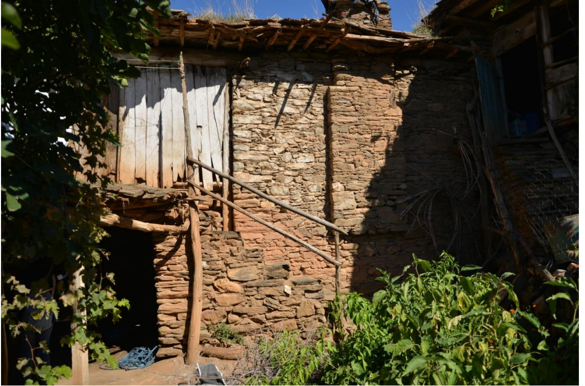
Fotoğraf 62- Evin dam bölümü ve giriş kapısı
