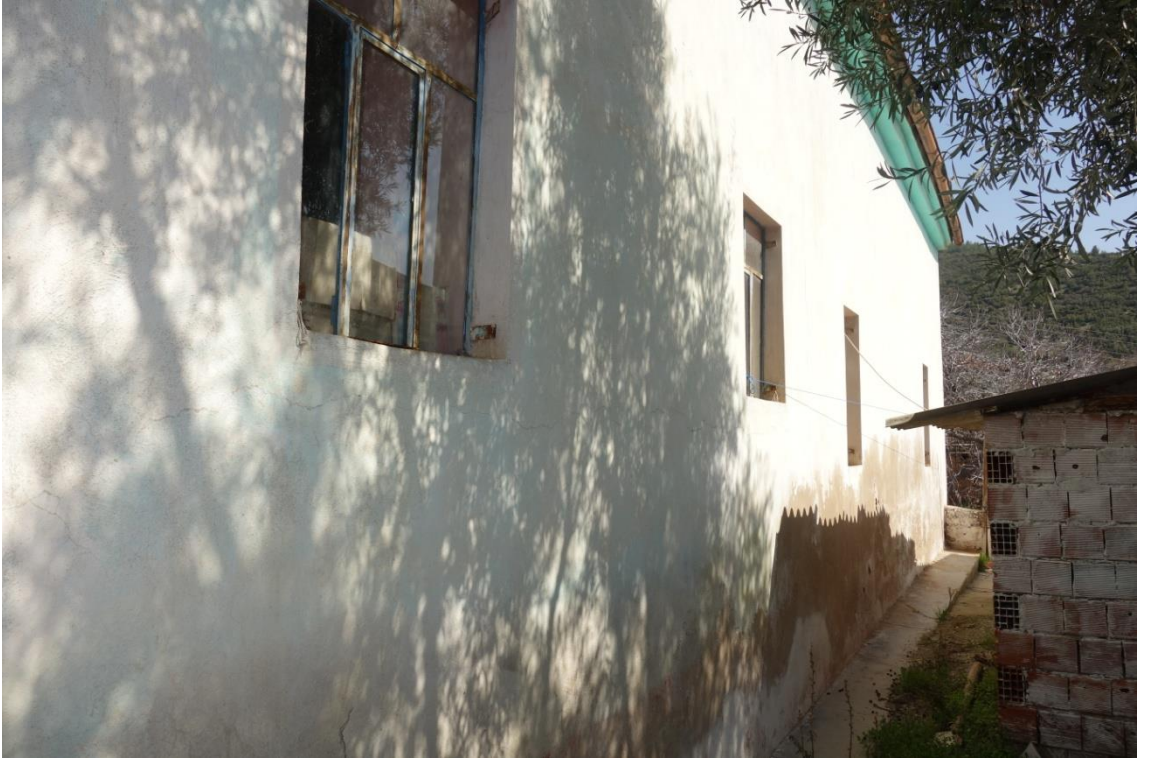
Fotoğraf 2- Yukarı Cami'nin güney duvarındaki pencere kısımları
