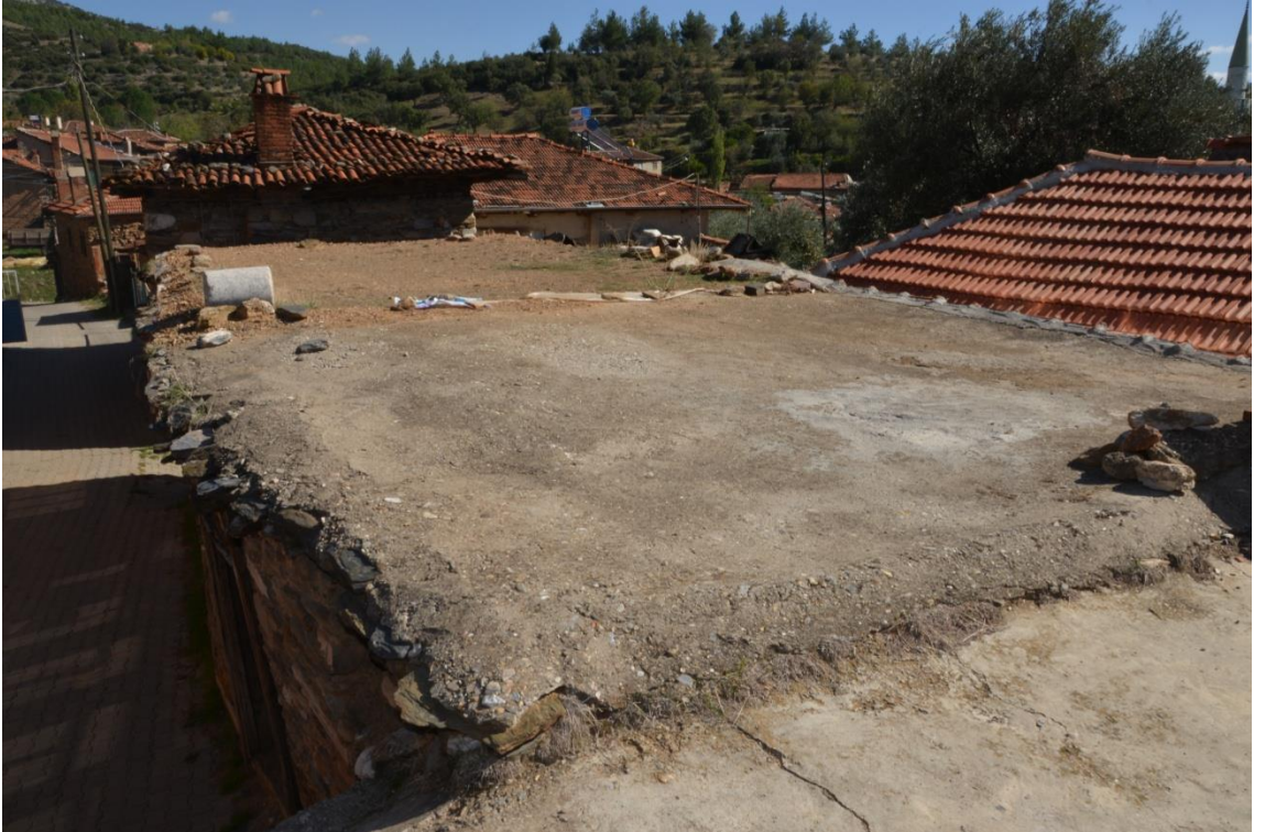
Fotoğraf 16- Eski Cami'nin üst örtüsünün betonla kapatılmış hali
