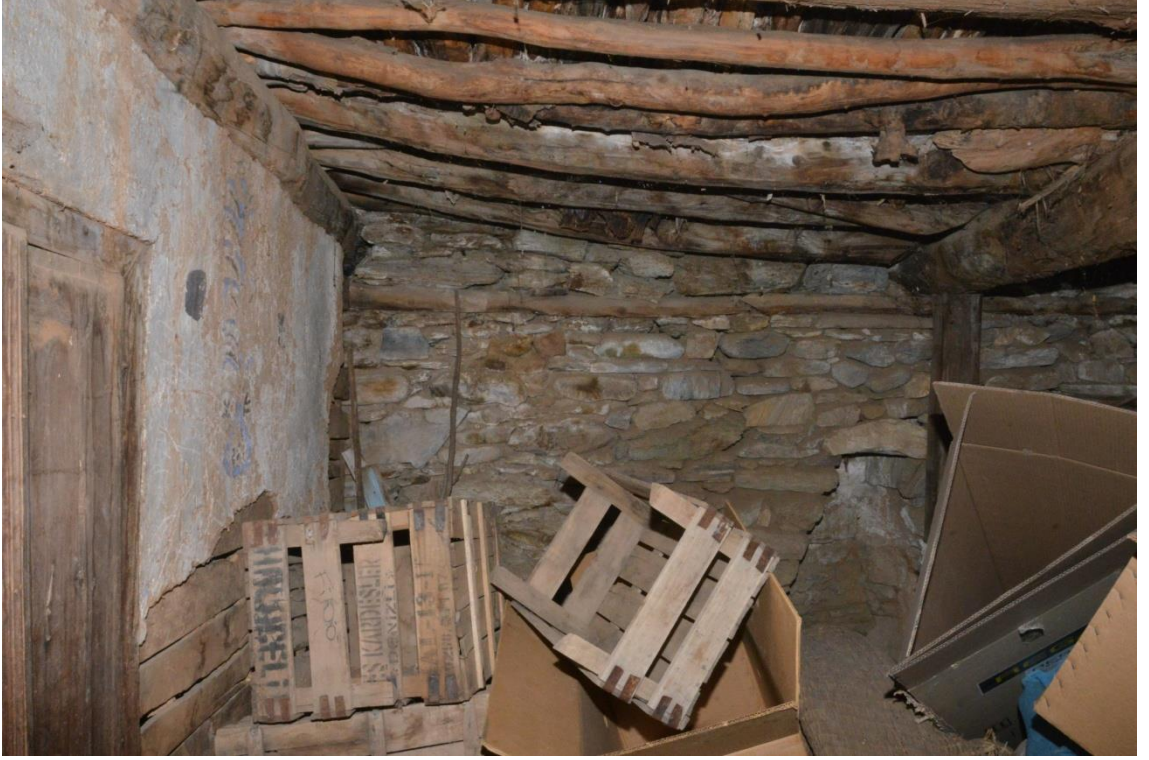
Fotoğraf 19- Eski Cami'nin harim mekânın batı tarafındaki odanın mihrap nişi
