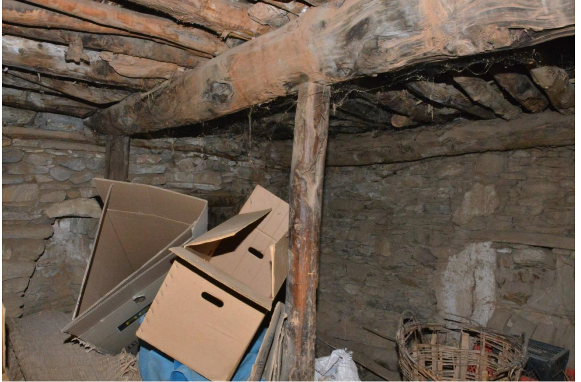
Fotoğraf 18- Eski Cami'nin Harim mekânının yanındaki odanın ahşap direkleri
