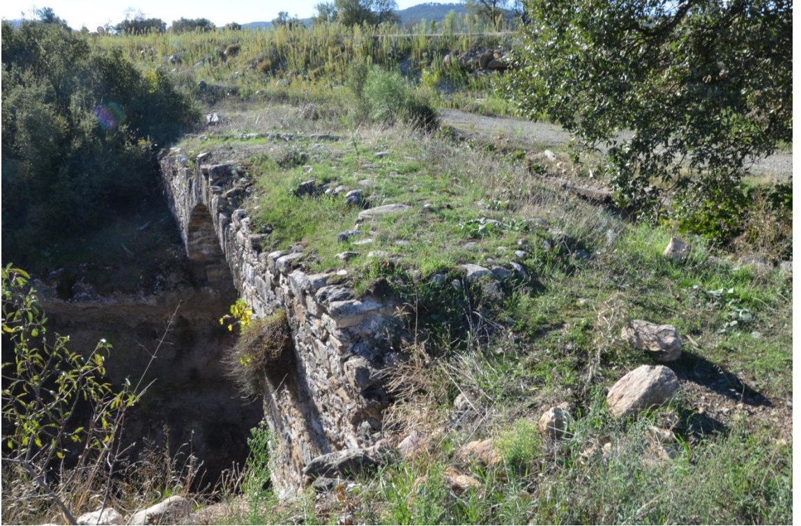
Fotoğraf 56- Köprünün üstten görünüşü
