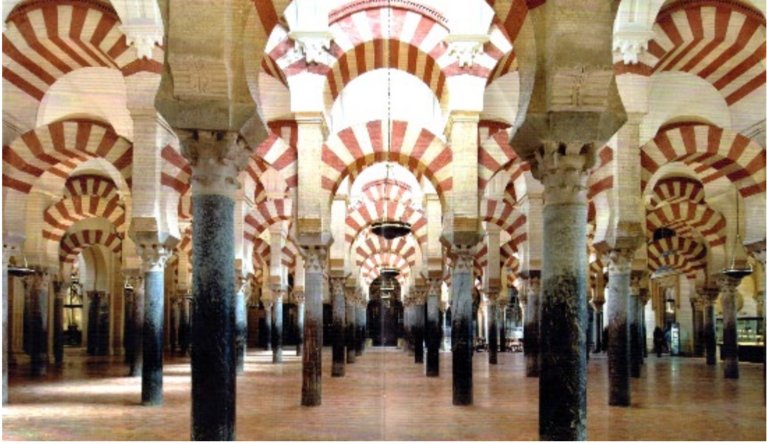
Şekil 11: Kurtuba Ulu Camii, İki Katlı Kemerler
