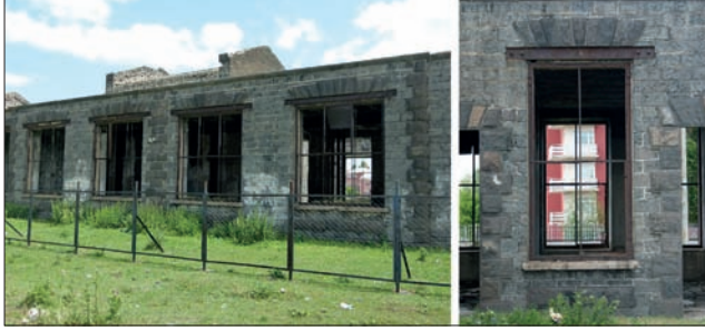
Fotoğraf 9: Geniş açıklıklı, çelik lentolu ve demir doğramalı pencereler / Wide span windows which have steel lintel and joinery windows
