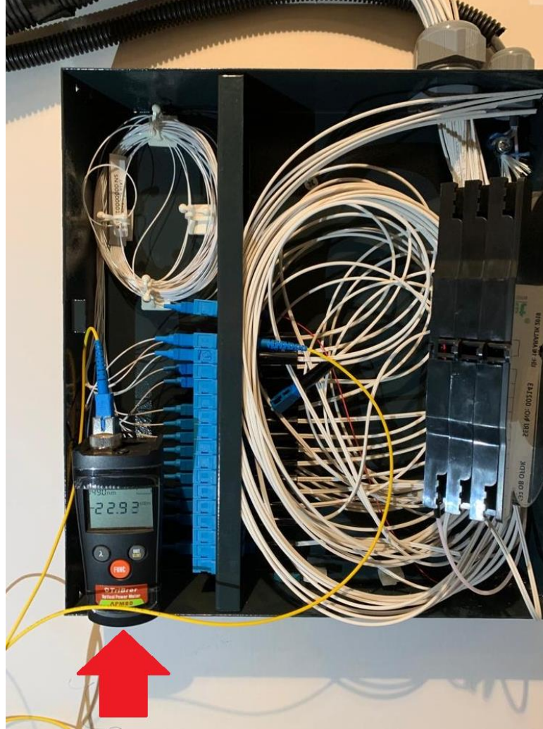
Şekil 3.22: Bina1x16 Splitter Çıkışı Pon Power Metre dBm Ölçümü
