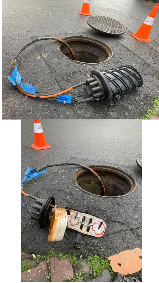
Şekil 3.6: Saha Dolabı Önündeki Ek Kaseti
