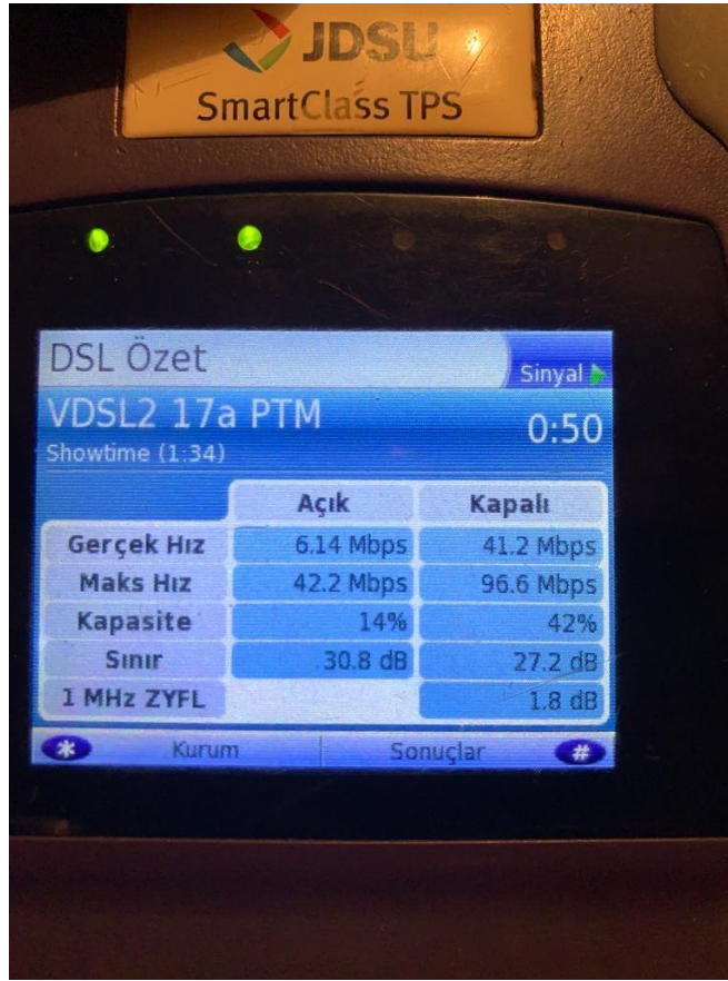
Şekil 3.13: Bakır Kablo Ölçümü
