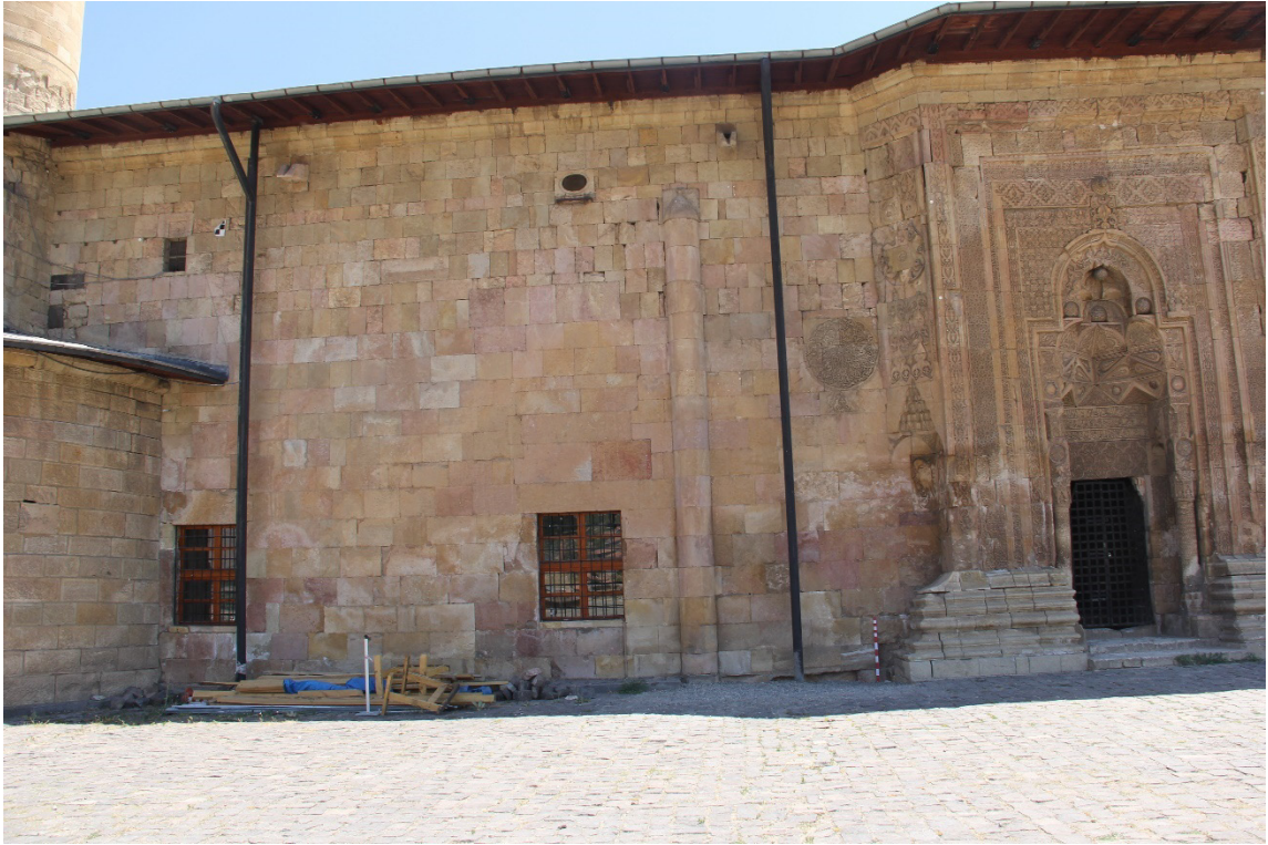
Şekil 76: Divriği Ulu Camii Batı Duvarı
