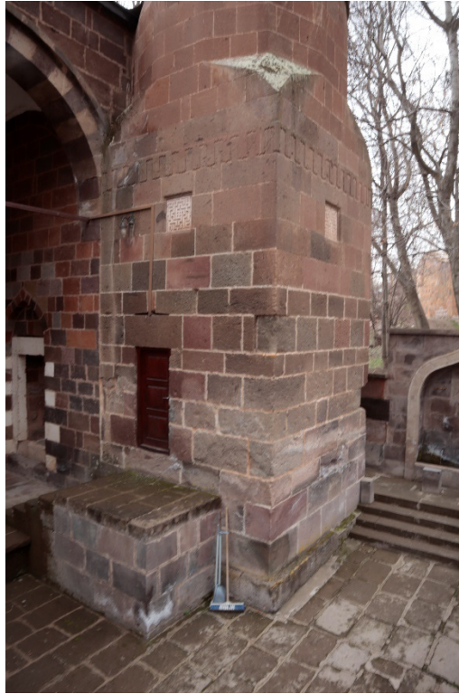
Şekil 202: Ahlat'taki İskender Paşa Camii Minare Kaidesi
