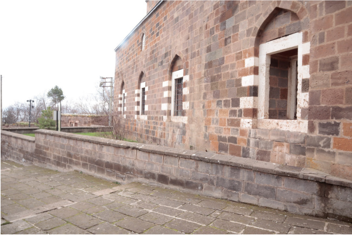
Şekil 200: Ahlat'taki İskender Paşa Camii Doğu Cephesinden Görünüşü
