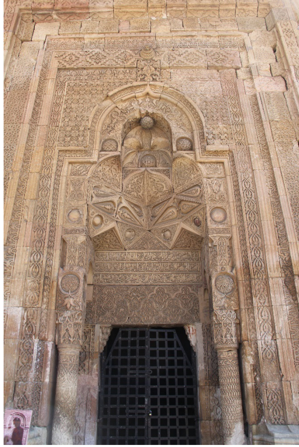
Şekil 95: Divriği Ulu Camii Batı Portal Nişi
