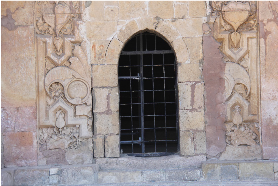
Şekil 109: Divriği Darüşşifası Portali Giriş Kapısı
