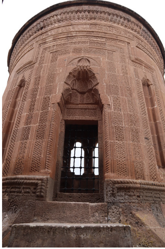
Şekil 175: Ahlat'taki Emin Bayındır Kümbeti Giriş Cephesi
