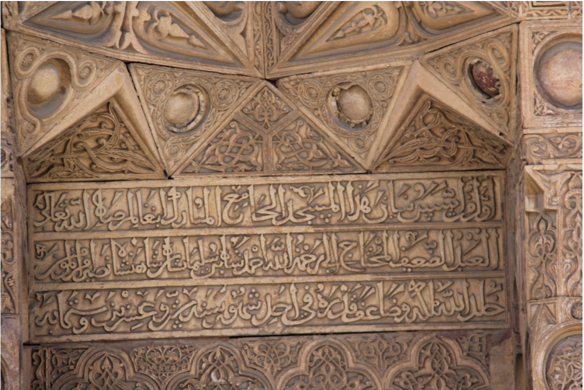
Şekil 63: Divriği Ulu Camii Batı Taçkapısındaki İnşa Kitabesi
