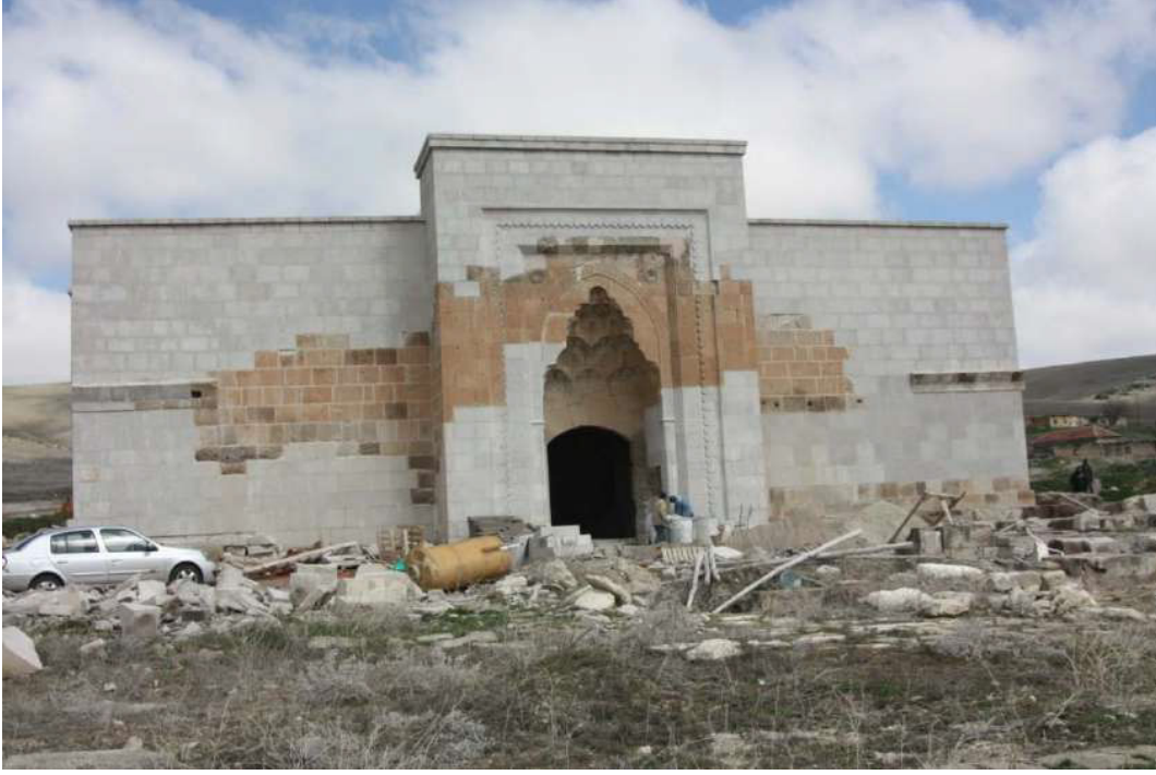
Şekil 18: Aksaray'daki Alay Han Giriş Cephesi
