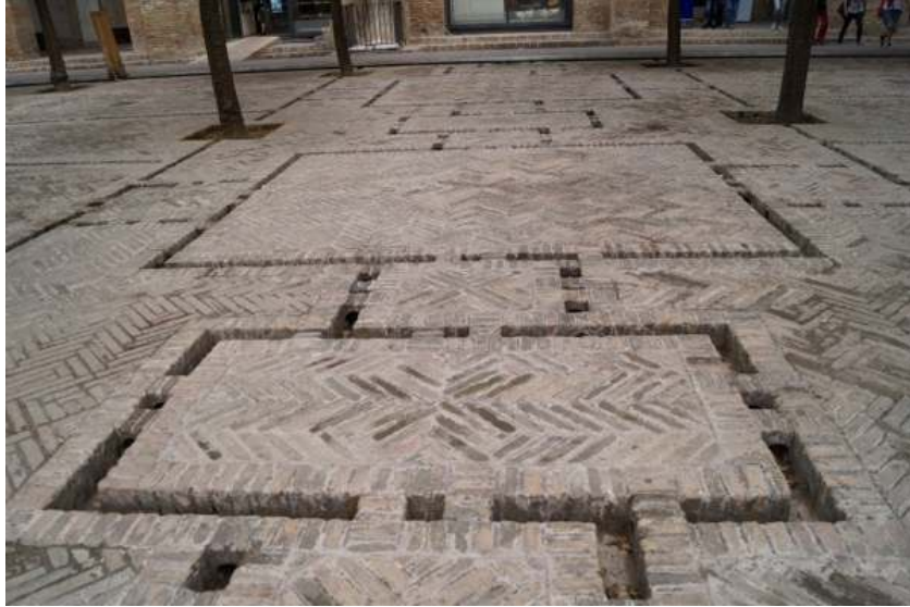
Fig. 6: İşbiliye Ulu Camii avlusunda bulunan mazgallar ve sulama kanalları (Foto. Fatma Yıldız).
