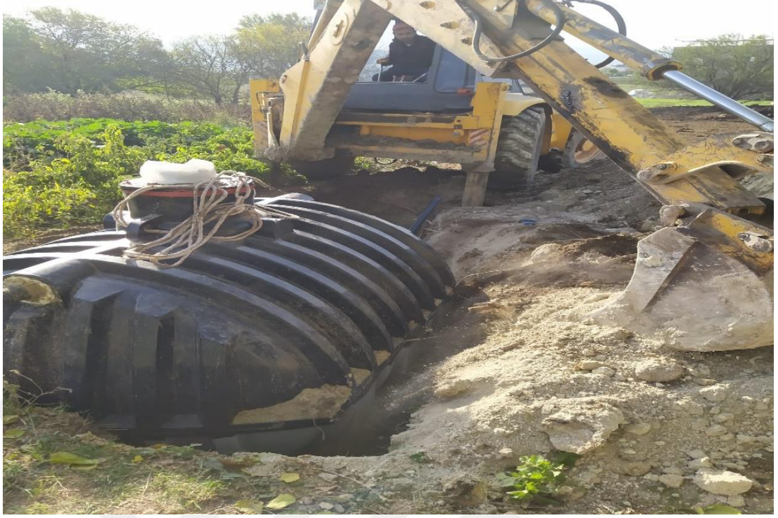
Şekil 2.30. Reaktörün yarı toprağa gömülü vaziyete getirilmesi
