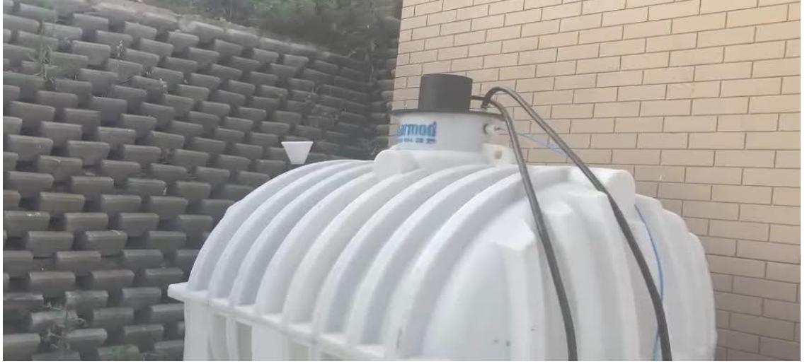
Şekil 2.24. Karıştırıcı sisteminin reaktöre eklenmesi, pompa ve güneş kolektörü bağlantıları
