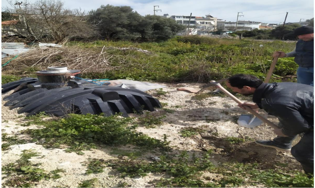
Şekil 2.31. Reaktörün yarı toprağa gömülü vaziyete getirilmesi
