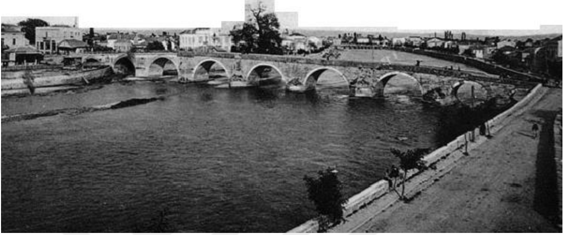
Resim 7. Üsküp- Taş Köprü 1909/10 127
