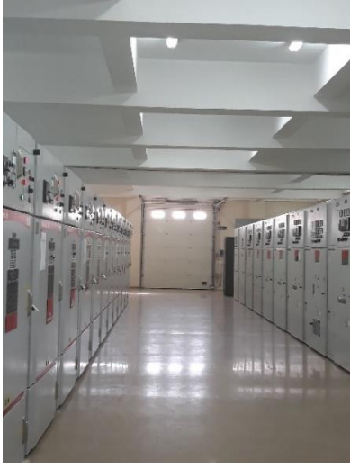
Resim 41. Aydınlatma Seviyesi Yetersiz Olan Metal Clad
