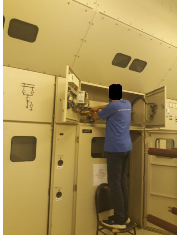
Resim 47. Metal Clad Hücresinde KKD Kullanımı Yapmayan ve İzole Tabure Kullanmayan Personel Çalışanlara düzenli çalışma, işi ciddiye alma, önemli bir iş üstlendiklerini anlatma eğitimlerde yerini almalıdır.
