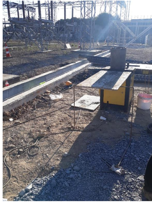
Resim 43. Kaçak Akım Rölesi Olmayan Elektrik Panosu ve Topraklaması Yapılmamış Tezgah
