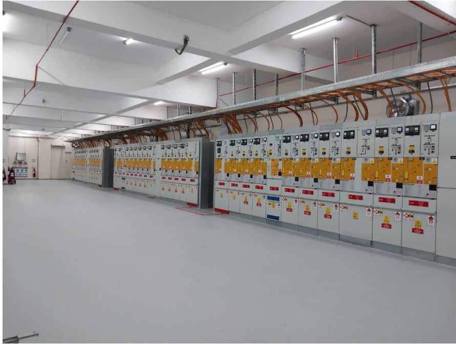
Resim 6. Metal Clad
