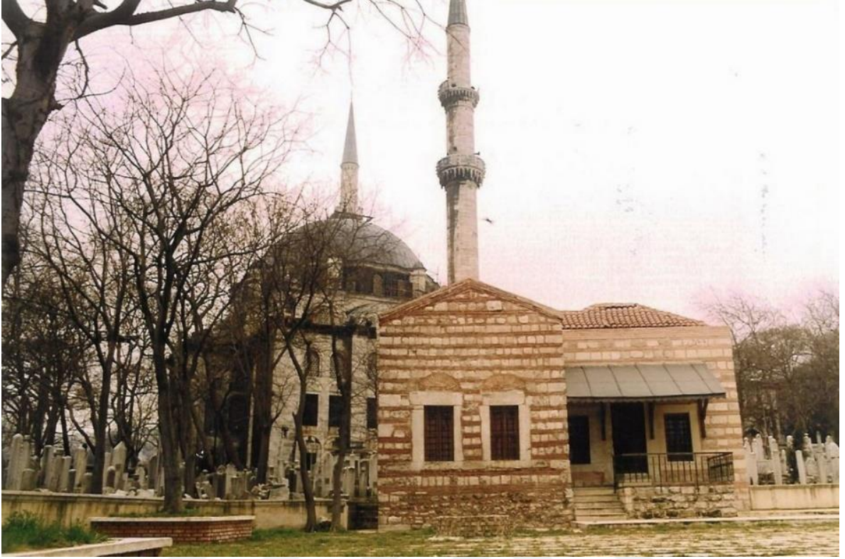
Şekil 98: Mihrişah Valide Sultan Sıbyan Mektebi Restorasyon Çalışmasından Önceki Görüntüsü (Eyüpsultan Belediyesi Arşivi)
