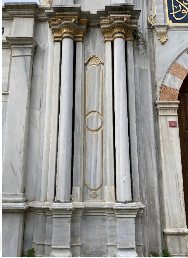
Şekil 31: Kapının Duvara Gömülü Sütunlarının Görünümü
