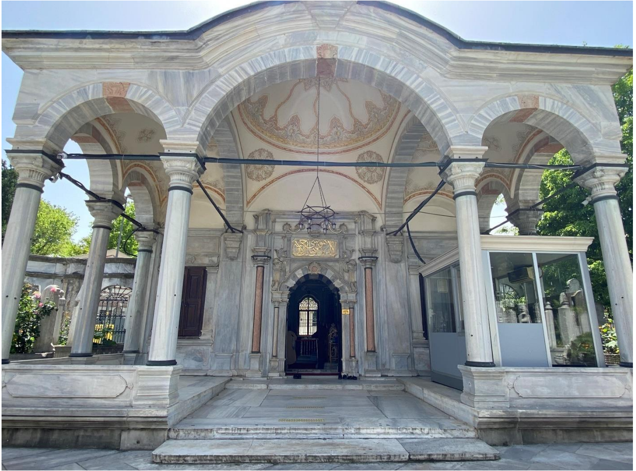
Şekil 80: İstanbul Mihrişah Valide Sultan Türbesi Giriş Açıklığı
