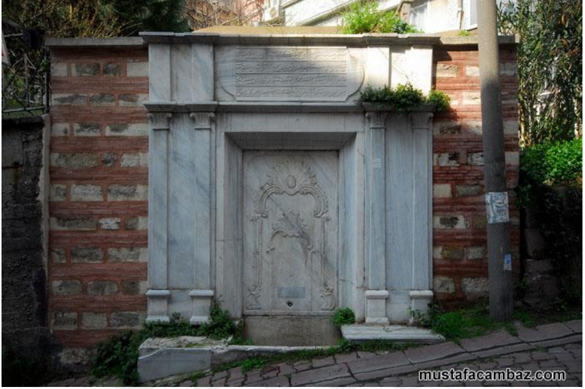
Şekil 9: Fındıklı Mihrişah Valide Sultan (Fatıma Sultan) Çeşmesi
