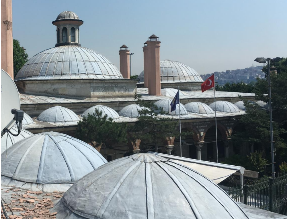
Şekil 45: İmaretin Üst Örtüsü- Kubbe ve Aynalı Tonoz (İstanbul Vakıflar I. Bölge Müdürlüğü'nden)
