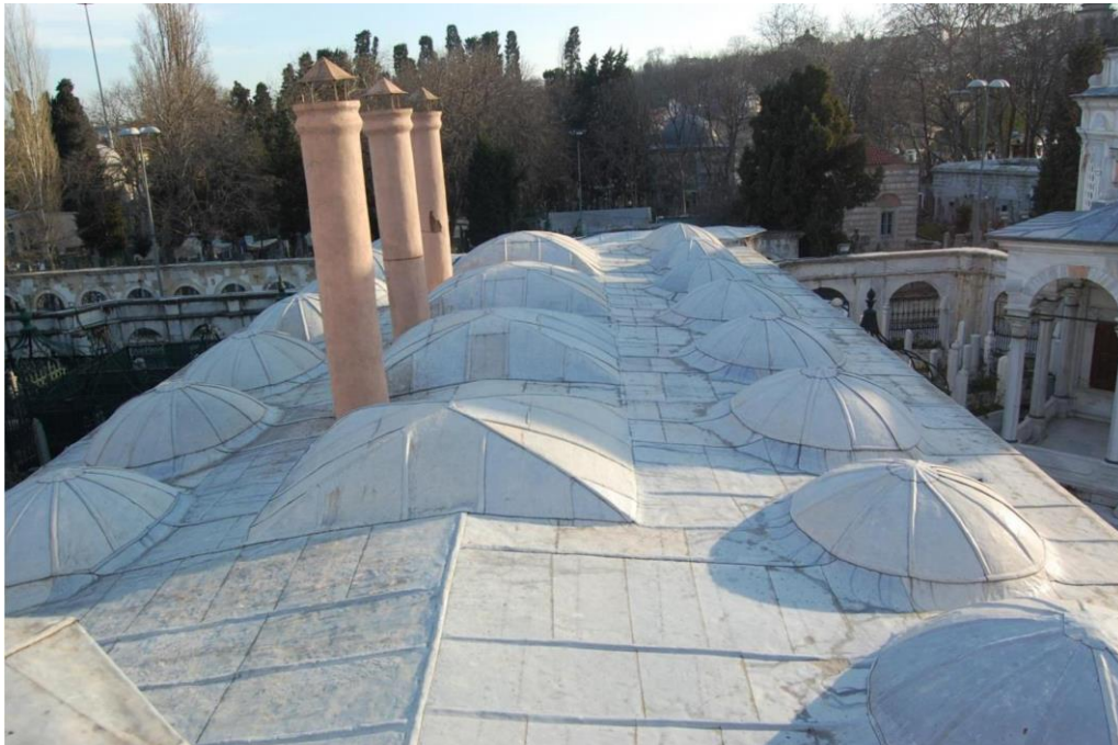
Şekil 45: İmaretin Üst Örtüsü- Kubbe ve Aynalı Tonoz (İstanbul Vakıflar I. Bölge Müdürlüğü'nden)
