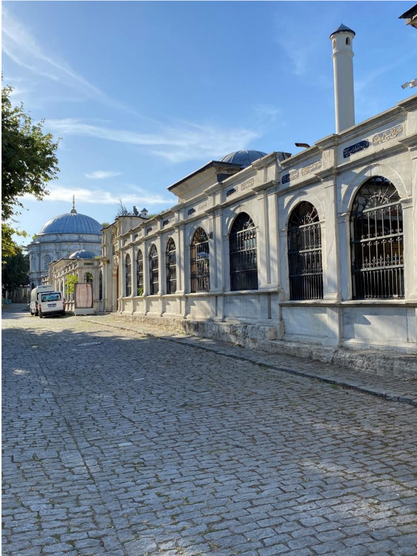
Şekil 13: İstanbul Mihrişah Valide Sultan Külliyesi Güney Avlu Duvarı
