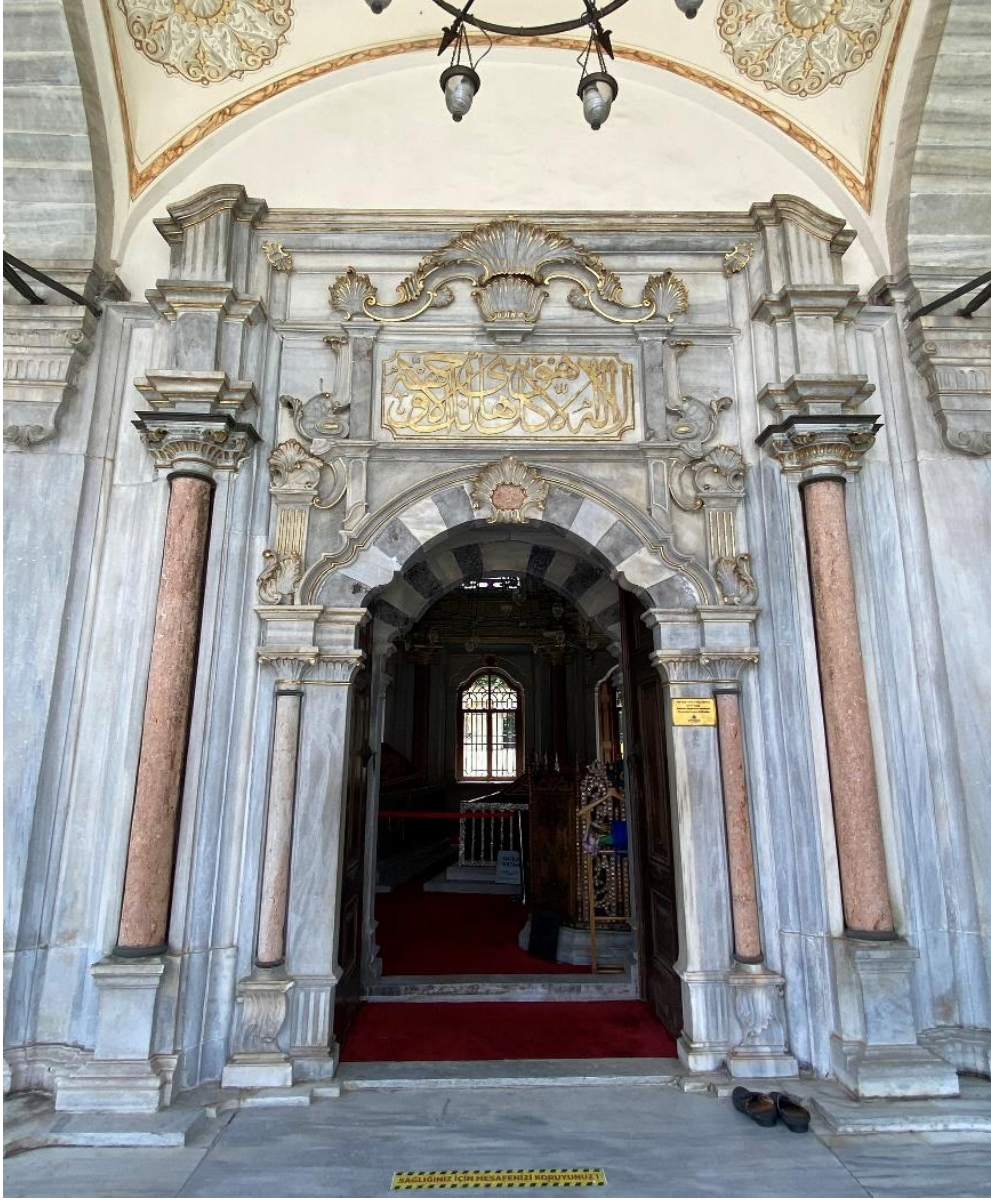
Şekil 84: Türbe Giriş Kapısı
