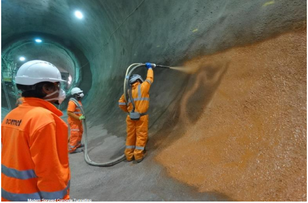
Şekil 11. Püskürtme membran uygulaması ile yalıtım yapılması (normet.com)
