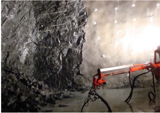
Şekil 7. Çelik lifli püskürtme beton uygulaması ile birinci kaplama yapılması (Vandevall, M. 1990. Çelik tel - Tunnelling the World. NV Bækert S.A, 1991 edition)
