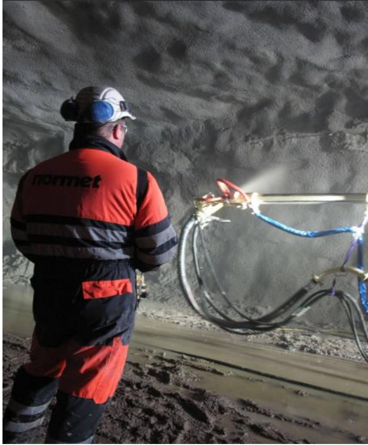
Şekil 3.4 Püskürtme beton uygulaması
