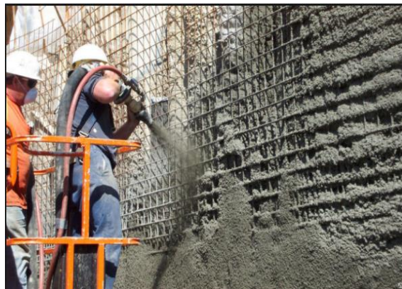
Şekil 3.3 Tabanca sistemi kullanılarak püskürtme betonun yüzeye uygulanması
