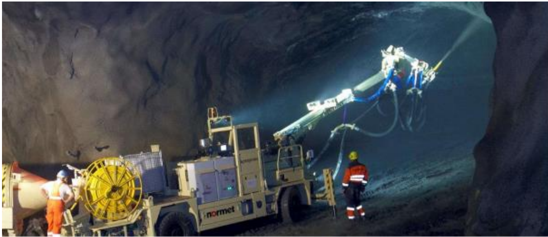
Şekil 3.5 Yaş püskürtme beton uygulaması
