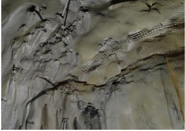
Şekil 6. Çelik hasır üzerine püskürtme beton uygulaması ile birinci kaplama yapılması (Vandevall, M. 1990. Çelik tel - Tunnelling the World. NV Bækert S.A, 1991 edition)
