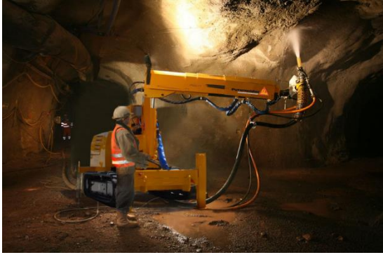
Şekil 3.1 a) Tünel tahkimatı
