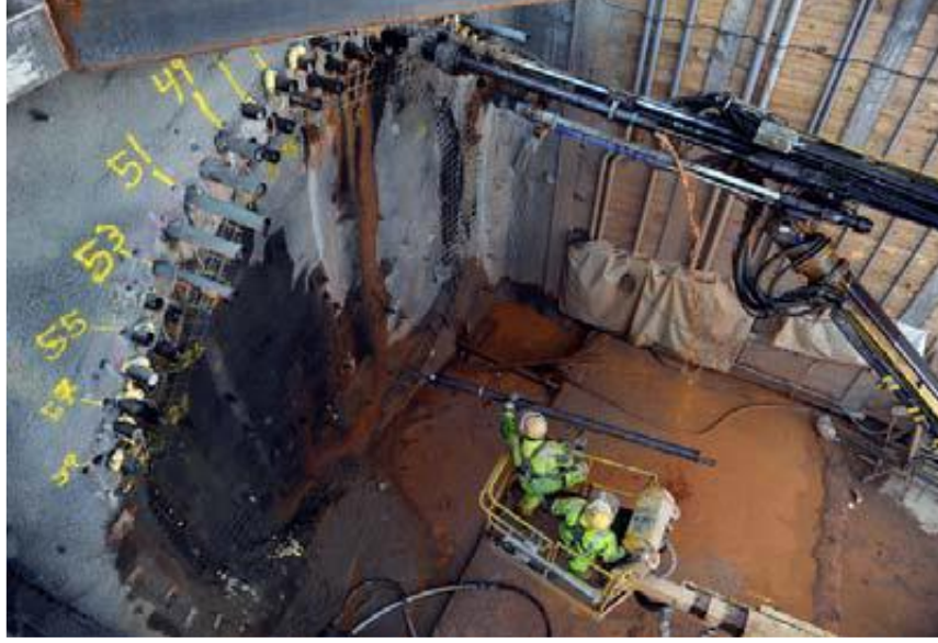
Şekil 2.17 Tynols Corner tüneline şemsiye borusu uygulaması
