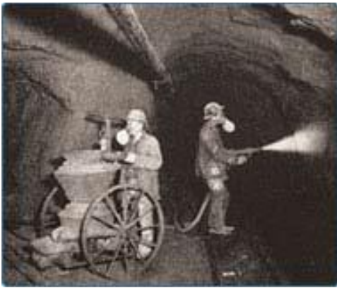
Şekil 3.3 Tabanca sistemi kullanılarak püskürtme betonun yüzeye uygulanması
