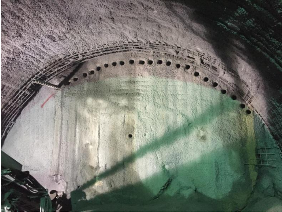
Şekil 5. Belirli aralıklarla şemsiye borusu için açılan delikler (Selçuk,2015)
