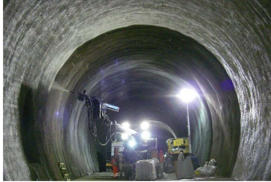
Şekil 10. Çelik lifli püskürtme beton uygulaması ile nihai kaplama yapılması (Fotoğraf: Shani Wallace, Tunnel Talk, Temmuz 2011).
