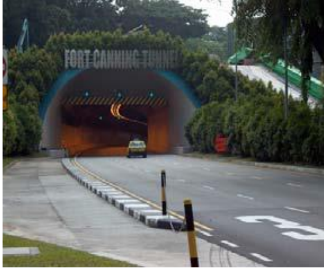
Şekil 2.16 Fort Canning karayolu tüneline bir görünüm
