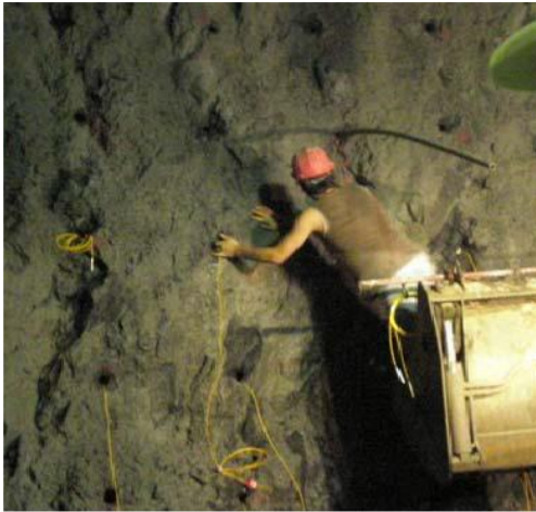
Şekil 2.12 Deliklere patlayıcı dolumu ve tam kesit patlatma şeması
