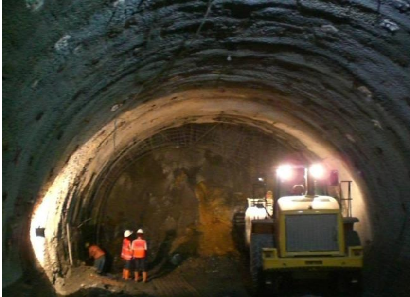
Şekil 2.19 ÜÜÇ Metro Projesi-Çarşı istasyonu P1 tüneli kazı-desteği
