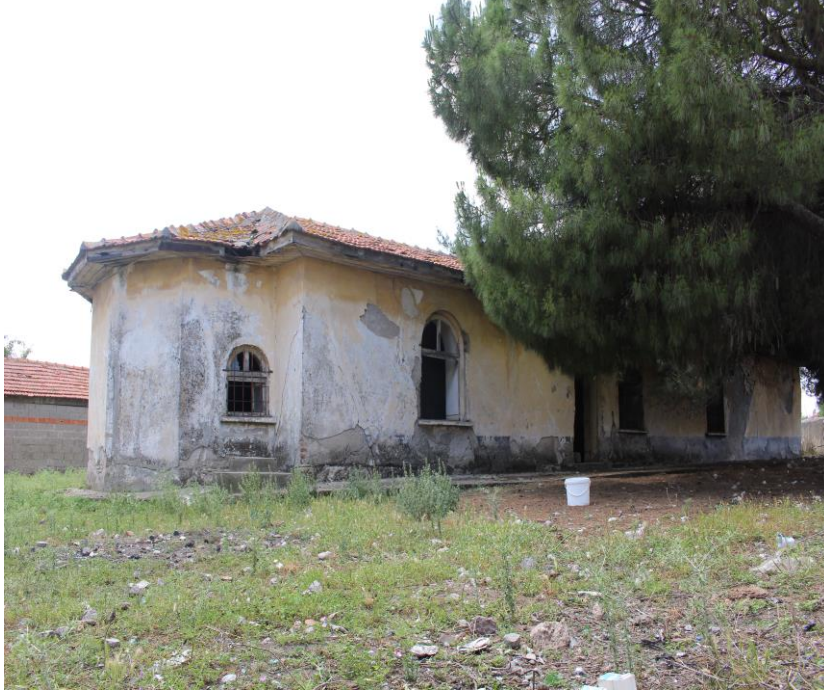
Resim 30. Yapının Kuzey Cephesi
