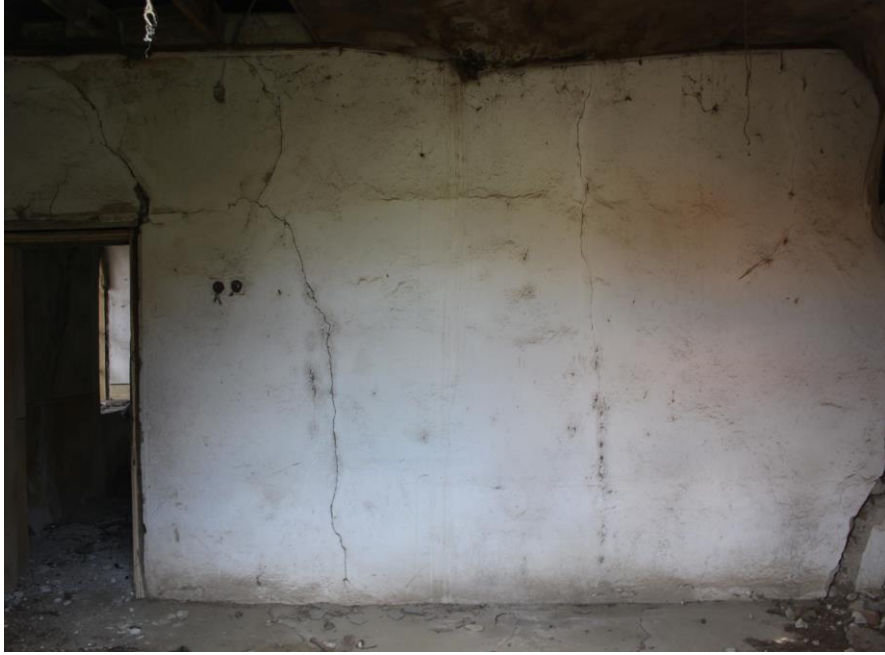
Resim 27. Oda Bölümünün Doğu Cephesi
