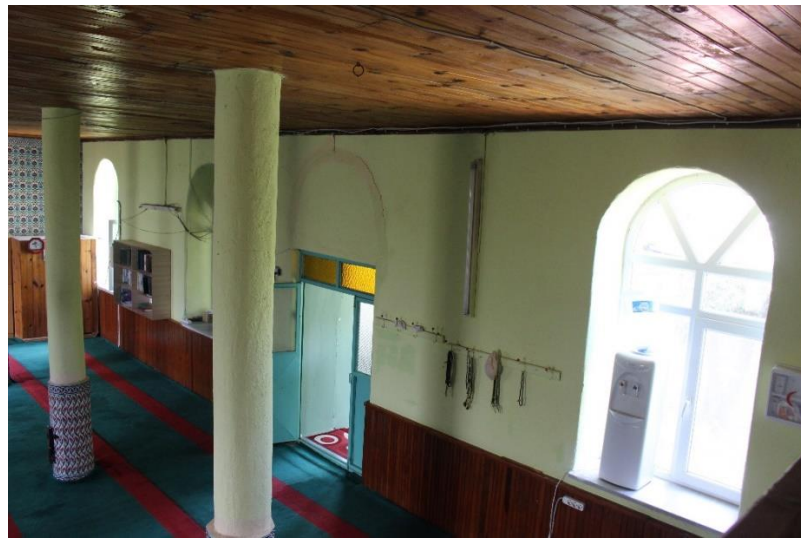
Resim 36. Caminin Kuzey Duvarı
