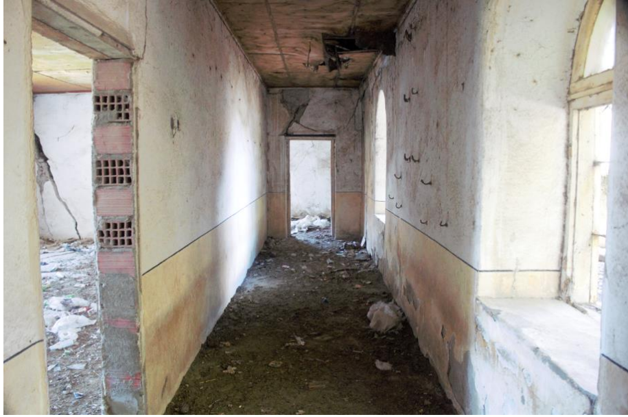
Resim 18. Giriş Kapısının Önünde Yer Alan Koridordan Batı Yönüne Bakış
