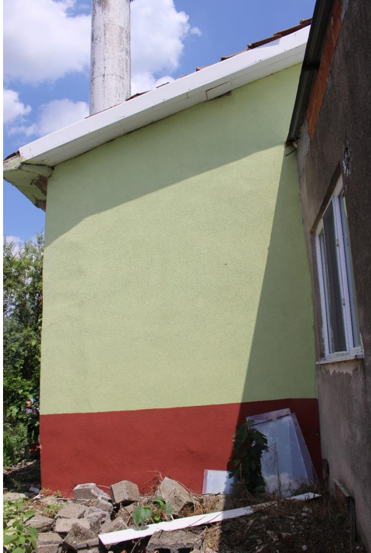
Resim 41. Yapının Batı Cephesi ve İmam Lojmanının Kuzey Cephesi
