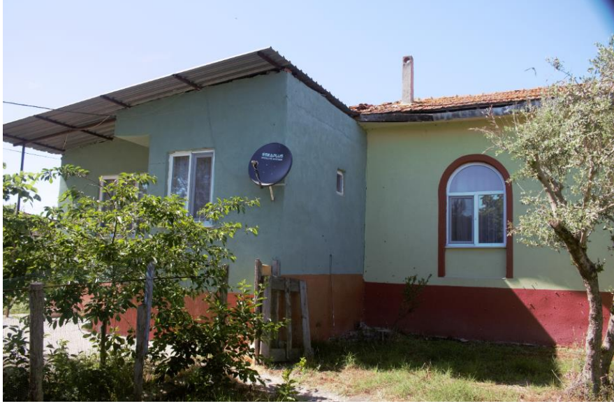
Resim 40. Güneybatı Cephe, İmam Lojmanı
