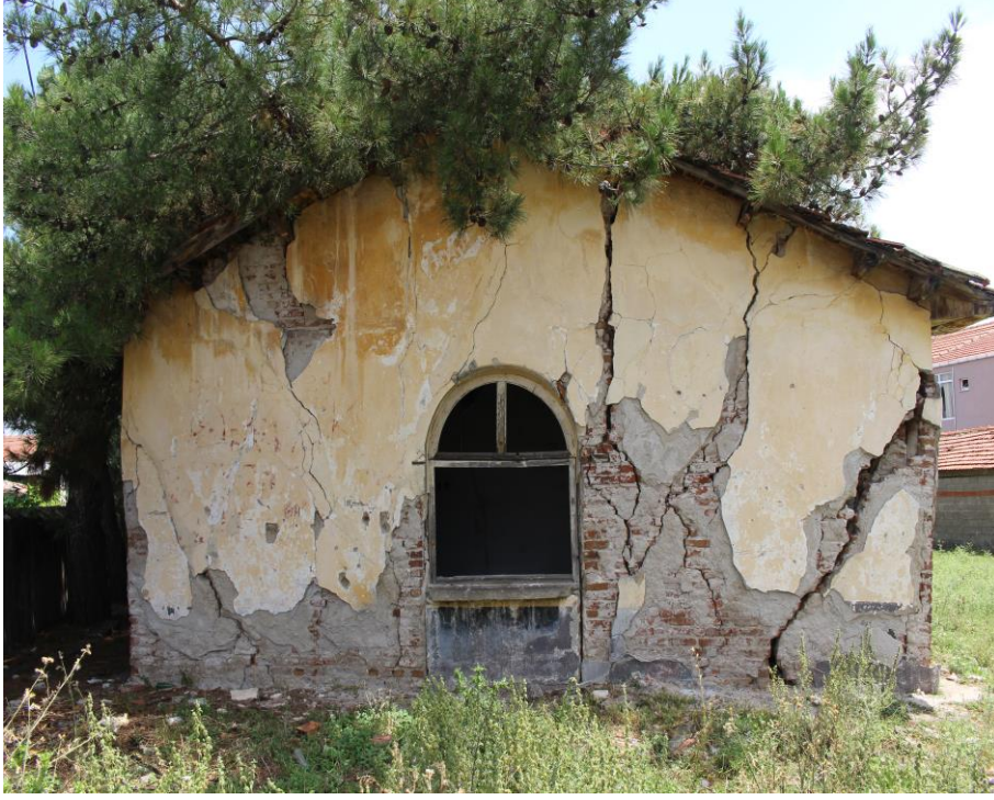
Resim 29. Yapının Batı Cephesi
