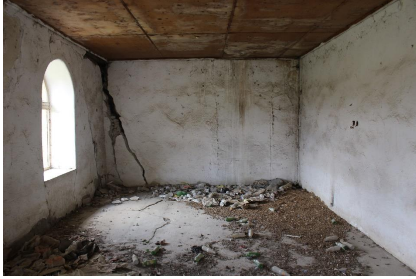
Resim 23. Mekânın Batı Cephesi
