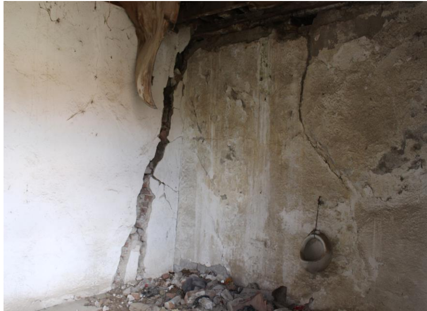
Resim 28. Oda Bölümünün Güneydoğu Cephesi
