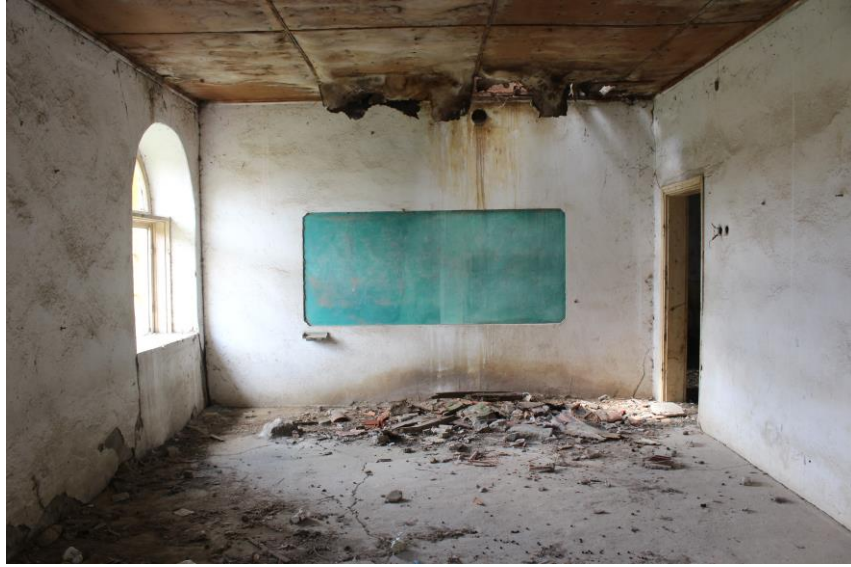
Resim 22. Mekânın Batı Cephesi
