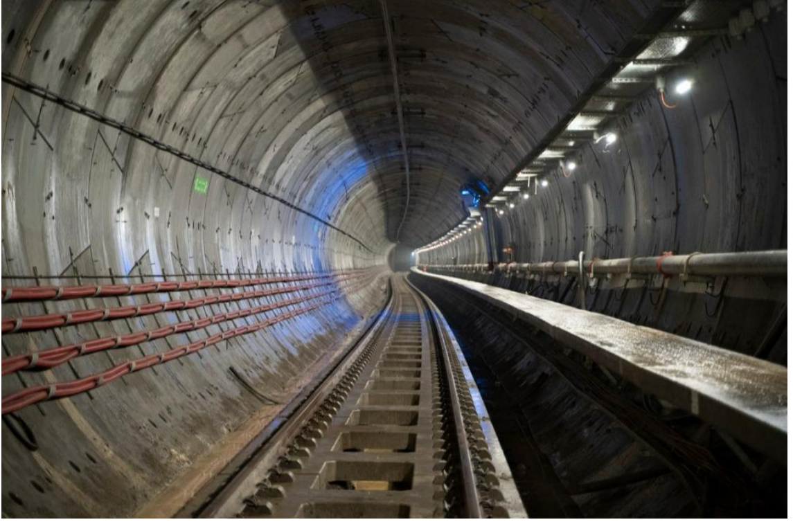
Şekil 3 Tünel İçi Kesit ve Segment Taşı Dizilimi
