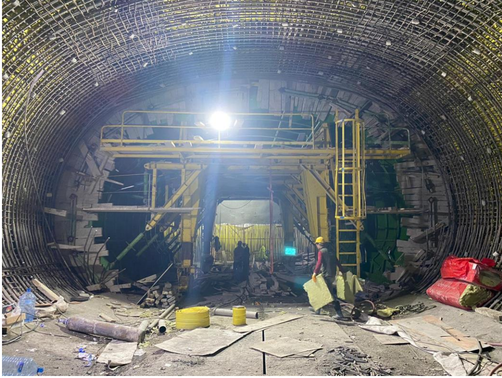
Şekil 10 NATM Tipi Tünellerde PVC Membran Uygulaması
