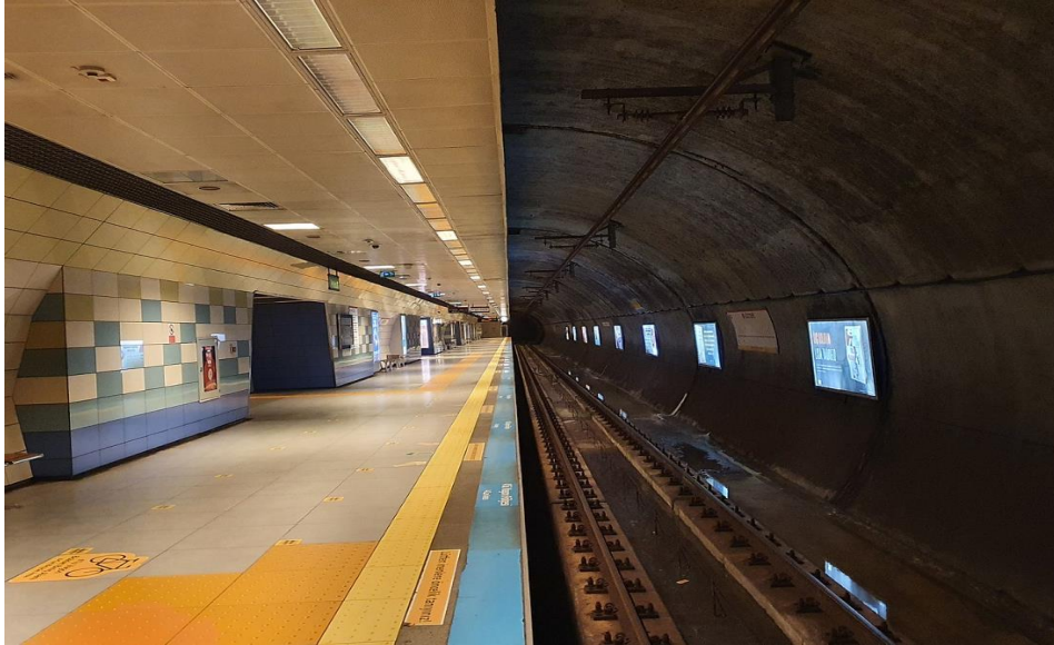
Şekil 25 M4 Metrosu Göztepe İstasyonu
