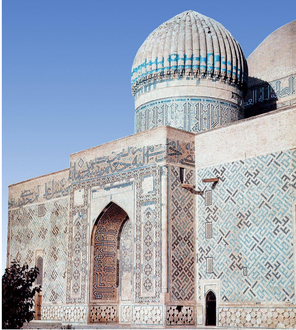
Resim 17, Ahmed Yesevî Külliyesinin Kuzey Cephesi , islamansiklopedisi.org.tr/ahmed-yesevî-kulliyesi .
