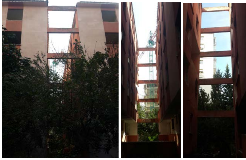
Şekil 18. Binaları birbirine bağlayan bağ kirişleri
