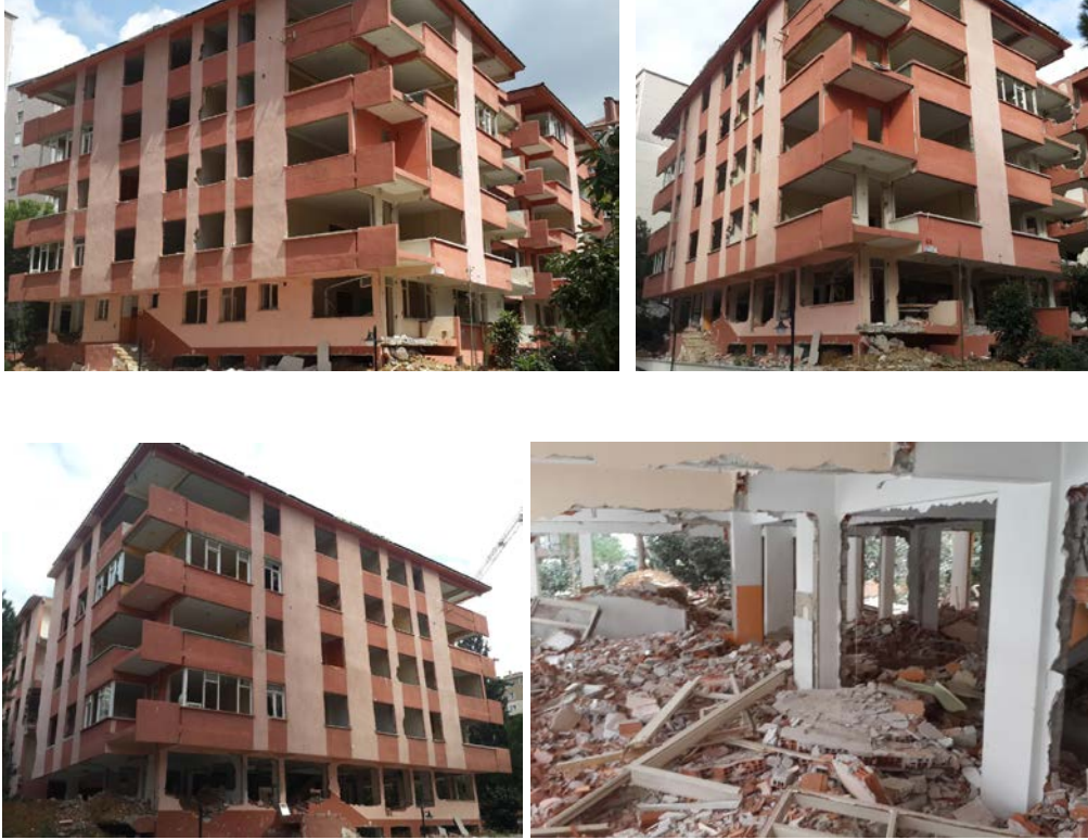
Şekil 32. B Blok Binasında gerçekleştirilen zemin kat duvar yıkımı
